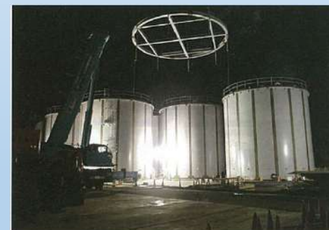
図 3-126 福島第二原子力発電所での組立て・溶接の状況
