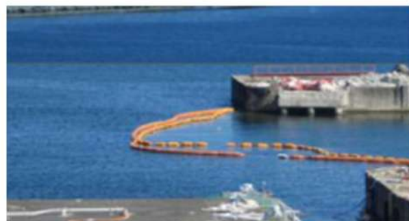
1～4号機取水路開渠北側
