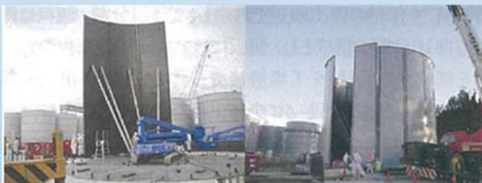
図 3-124 仮組の状況(底板設置～側板建込み)
