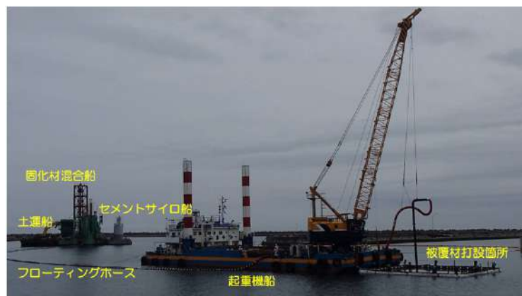
図 3-137 施工状況(第2期工事)
