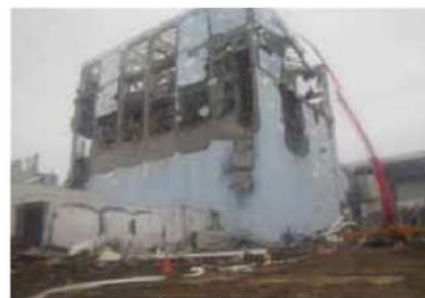
コンクリートポンプ車による注水
