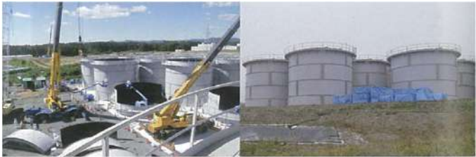
図 3-112 フランジ型タンク(左ー組立中、右ー完成)
