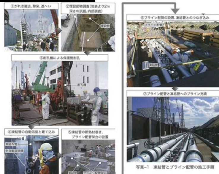
図3-62 陸側遮水壁の施工手順 表3-14 埋設物への対応方法
