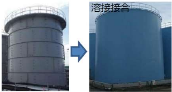
図 3-115 溶接型タンク(貯水容量1,200m 3 /基)
