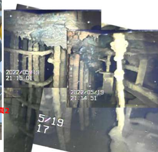
ペDESTAL外部より（写真2）
