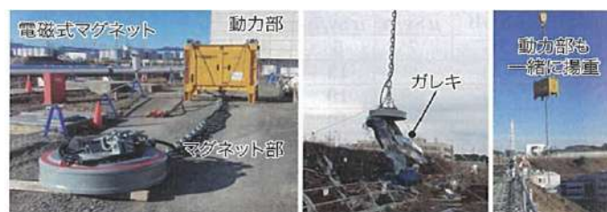
図 3-90 がれき撤去装置と施工状況(②)
