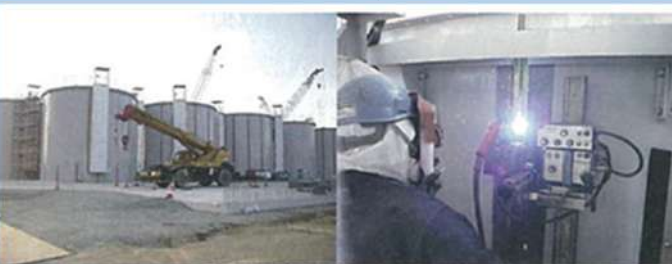
図 3-125 側板の溶接状況(左:溶接足場、右:溶接状況)
