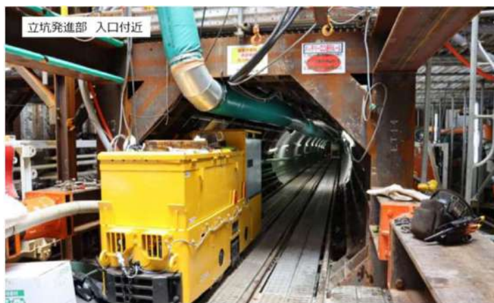
シールドトンネル立坑入口
