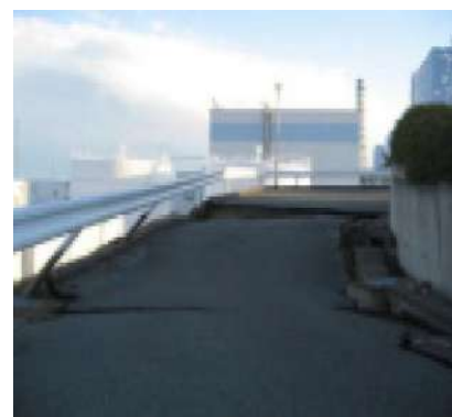
構内道路健全性調査 (構内道路状況)
