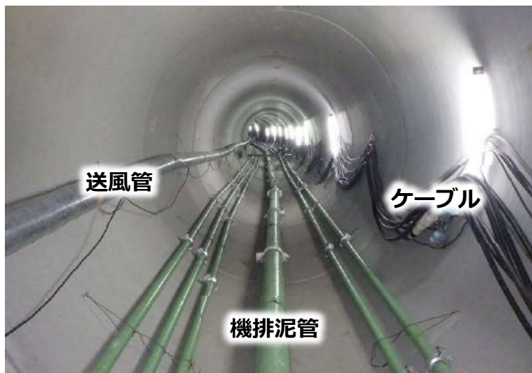
上流側推進管内部
