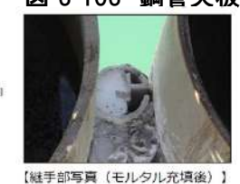
図 3-104 漏水防止ゴム付P-T型継ぎ手
