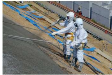
法面吹き付け 6)
