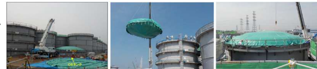
図 3-120 フランジ型タンク解体作業状況
