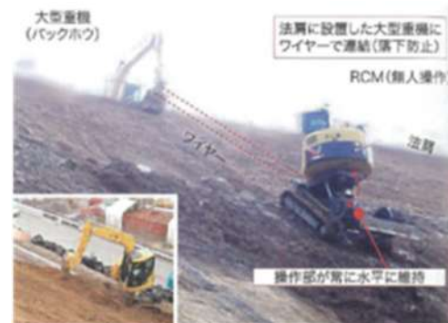
図 3-89 RCMによる施工状況(①)
