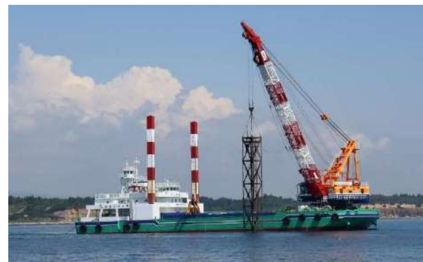
重錘による捨石均し
