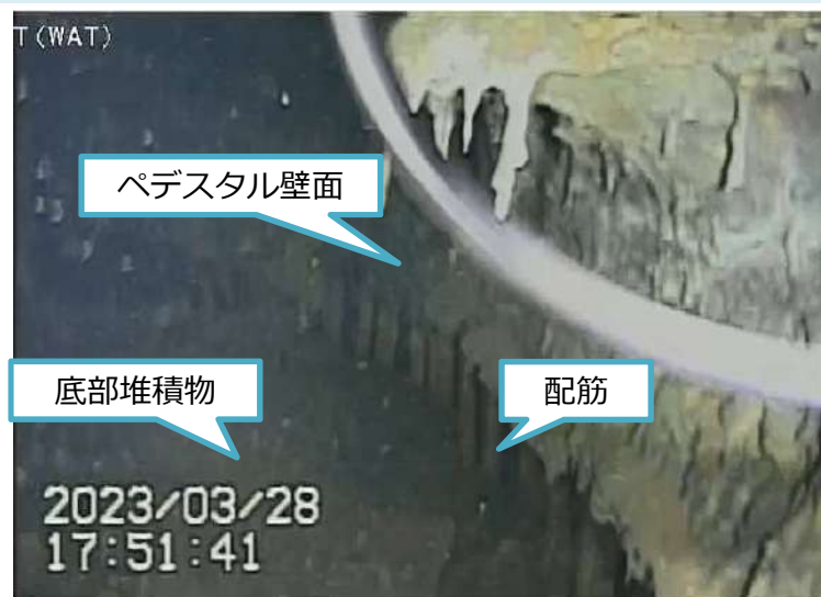
ペDESTAL内面の状況（写真1）
