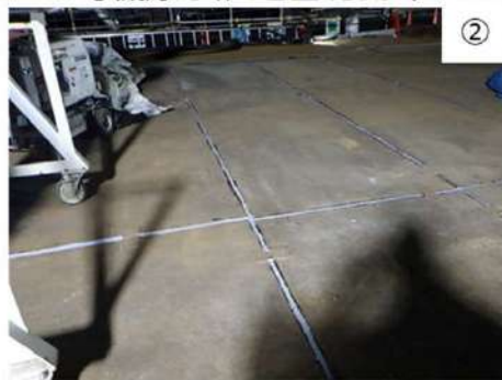
■ 1号機原子炉建屋北側 (2023.2.21)
