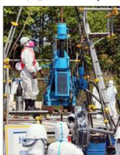
ボーリング調査
