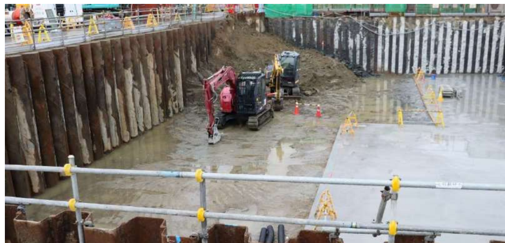
上流水槽の工事状況（左：地盤改良，右：掘削・均しコンクリート）
