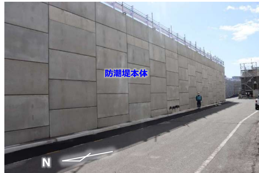
図 4号機南側(プロセス主建屋-海側) 撮影方向③(2024年3月7日撮影)
