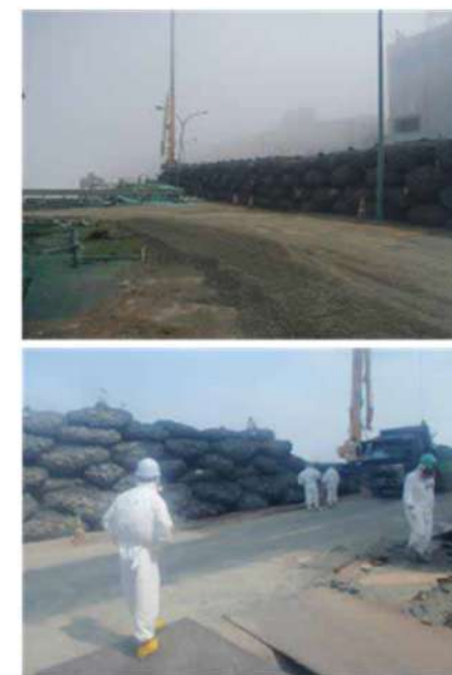
図2-33 仮設防潮堤の施工状況
