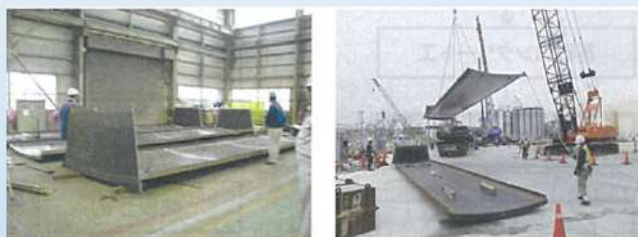
4枚継側板 1枚もの側板 図 3-123 工場での部材作成(側板の作成)
