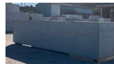
上流水槽側壁
