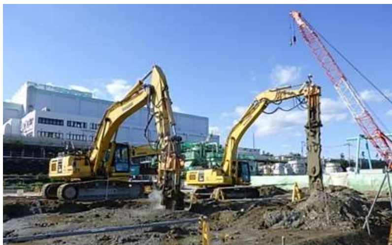
上流水槽の工事状況（左：地盤改良，右：掘削・均しコンクリート）
