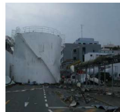
津波で流され道をふさいだ重油タンク (直径 11.7m×高さ 9.2m)
