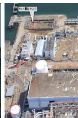
重油タンクは津波により1号機タービン建屋 北側脇まで漂流
