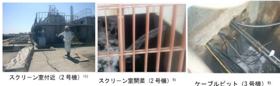
図 2-6 高濃度汚染水の流出状況
