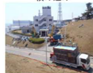
操作車と作業状況
