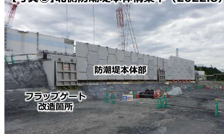
【写真②】北側防潮堤本体構築中（2022.8）
