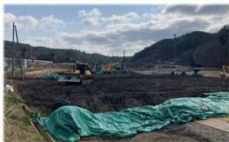
再生資材を重機で1層あたり30cm程度に敷均し転圧して盛土します。
