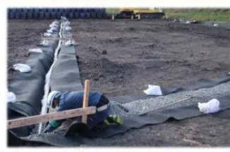
盛土の安定性を確保するために地下水・湧水を集水する排水管を設置します。
