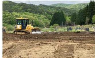
再生資材からの被ばく線量低減のため、盛土の上に50cm以上覆土します。覆土(山砂)は20mm以下のものを使用します。
