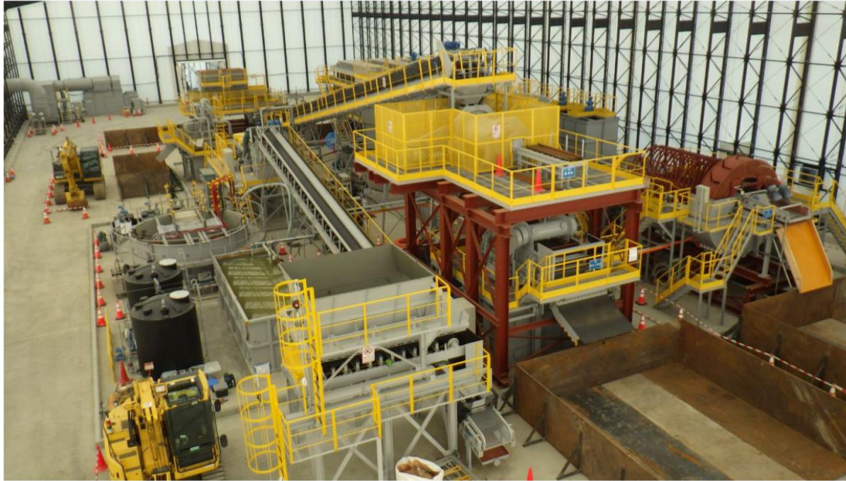
テント内全景
