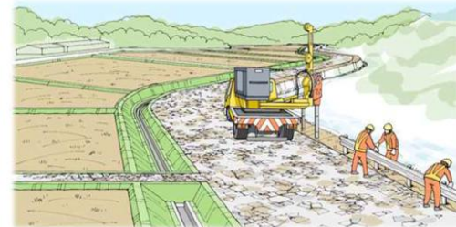
道路や転落防止のための防護柵(ガードレール)を設置します。
