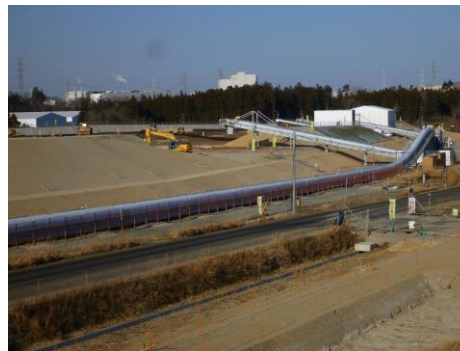
大熊地区 ベルコン稼働状況
