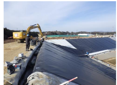
大熊地区 法面遮水工
