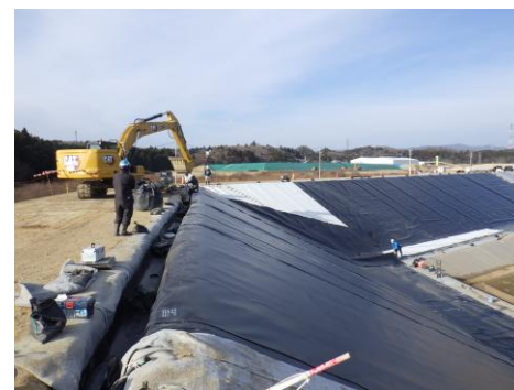
大熊地区 法面遮水工
