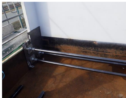
簡易型フレーム枠設置
