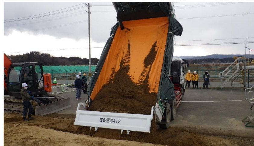
荷下ろし状況
