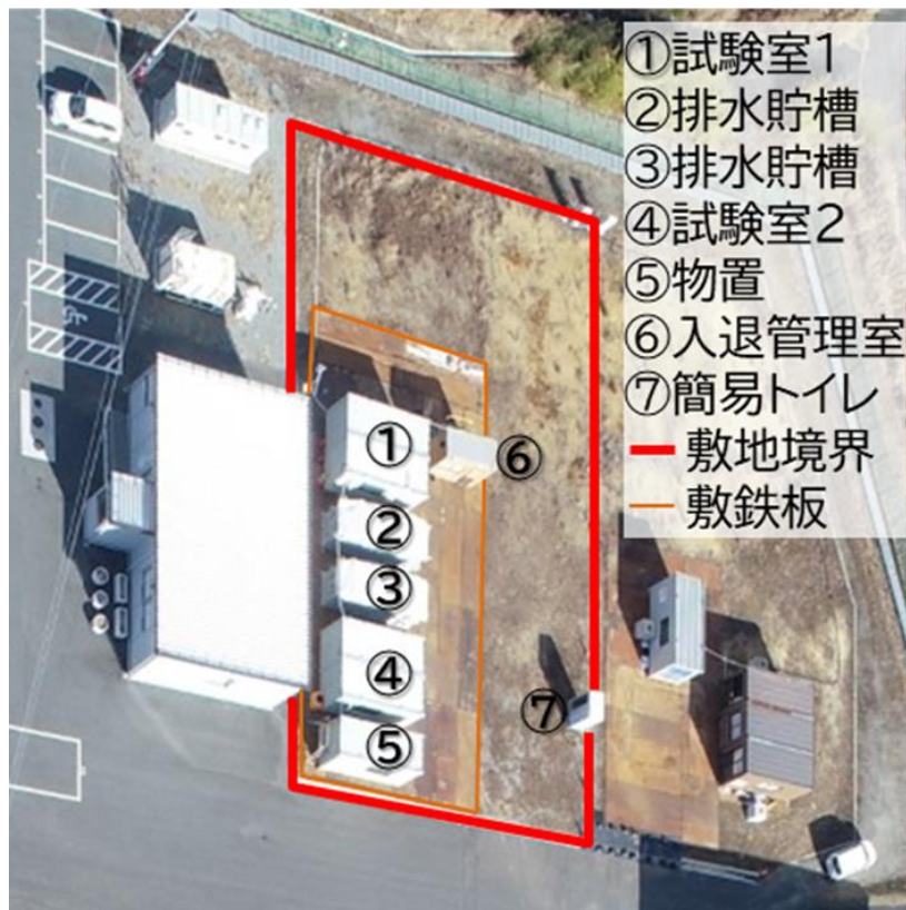
試験設備全景
