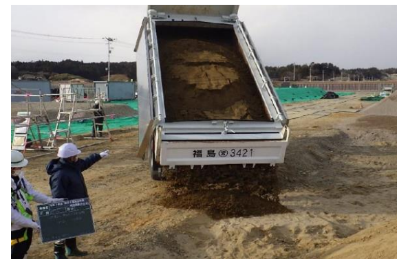
荷下ろし状況
