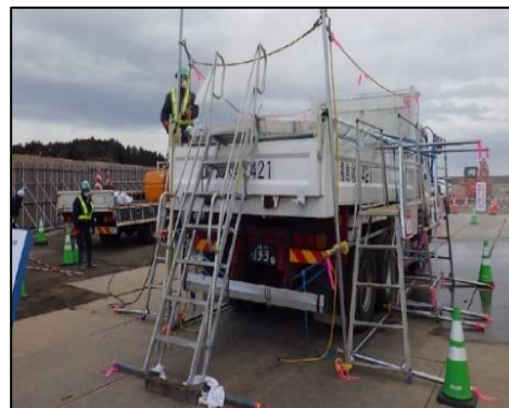
高圧洗浄機による散水
