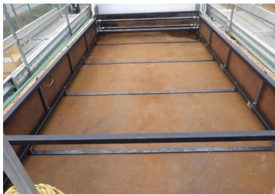
全体フレーム枠設置
