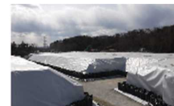
屋外シート養生
