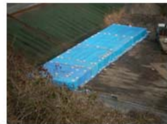
焼却灰固型化物の仮置き保管状況
