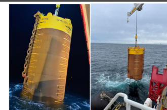
サクシオン式アンカー(⑧ HYWIND Tampen) 出典: https://semar.no/wp-content/uploads/2022/05/Suction-anchors-Installation.pdf (参照2025/12/25)
