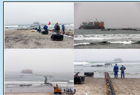
海底ケーブル敷設（陸から）
