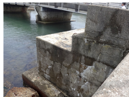
図-3.4.3 コンクリート製浮体施設損傷 塩害による損傷のイメージ
