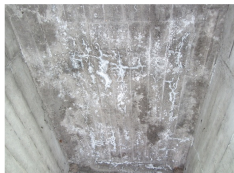
図-3.4.1 コンクリート製浮体施設損傷疲労損傷のイメージ
