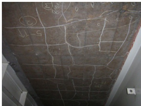
図-3.4.1 コンクリート製浮体施設損傷疲労損傷のイメージ
