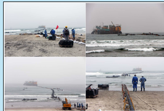
海底ケーブル敷設（陸から）
