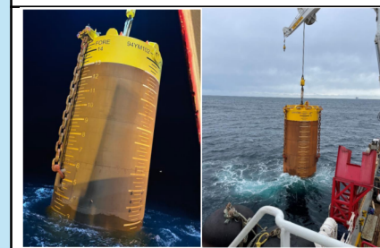
サクシオン式アンカー (⑧HYWIND Tampen)
