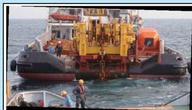
係留チェーン敷設
