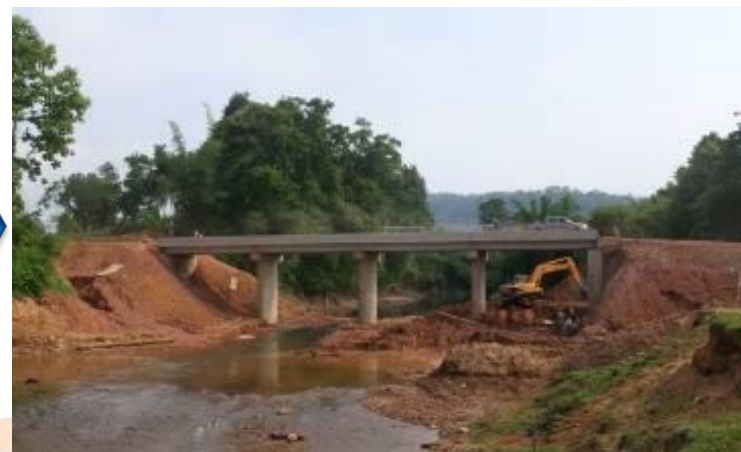
Nam Xao橋の建設
