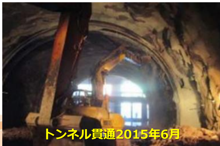
転流トンネル；630m, 内径10m, 馬蹄形 設計洪水量1,590m 3 /s (5年確率洪水量)
