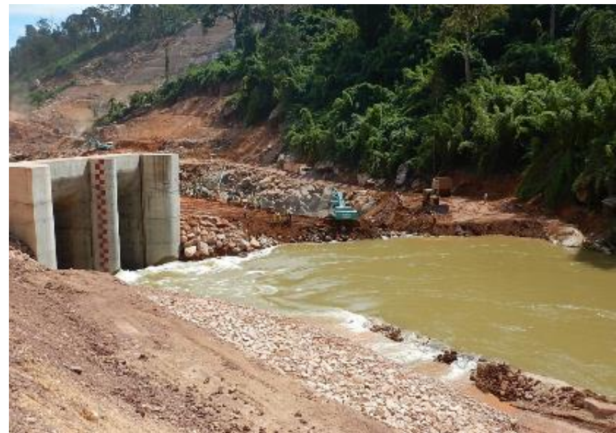
トンネル入口での転流工事
