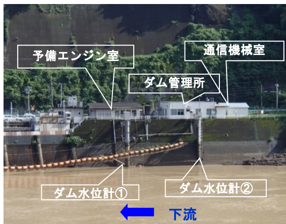
図 2.8-1 損壊前の状況.
