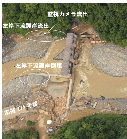
図 2.6.3-1 沙流川取水堰被災状況。
