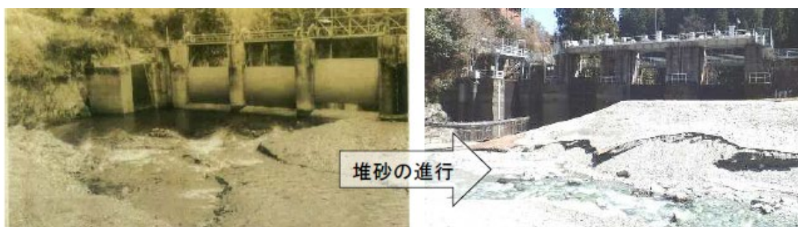
図3.1.2.2-1 工事前における明谷ダム調整池の状況。 （左：1940年代，右：2014年時点）
