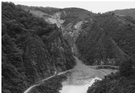
図 2.4.3-2 管理用道路被害状況 (奥只見発電所).
