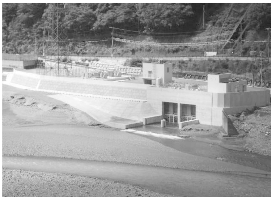
図 2.5-4 発電所全景（復旧後）。
