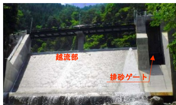
図3.1.2.2-3 工事後の明谷ダム.
