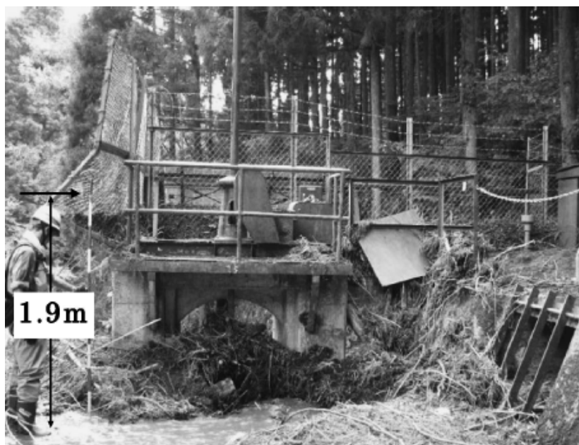
図2.2-1 最大水位(越流の痕跡状況より).
