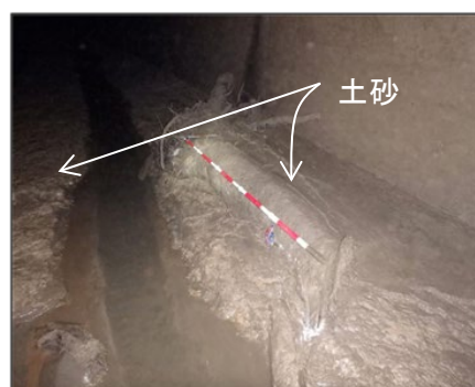
図 2.6.2-1 取水口スクリーン損傷状況. 図 2.6.2-2 導水路土砂堆積状況.
