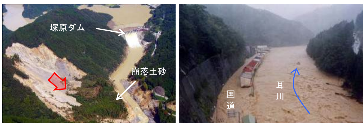
図 2.1-1 斜面崩壊の状況.
