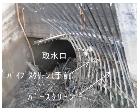
図 2.6.2-1 取水口スクリーン損傷状況. 図 2.6.2-2 導水路土砂堆積状況.
