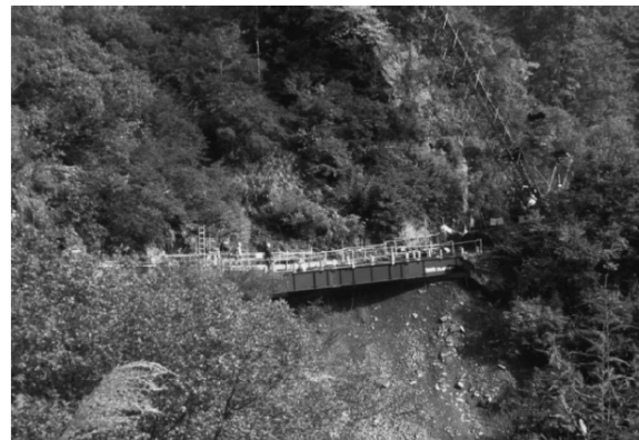
図 2.4.3-3 管理用道路復旧状況 (奥只見発電所).
