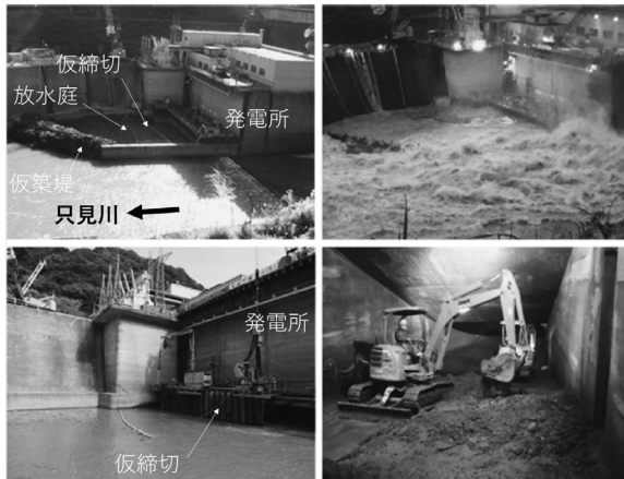
図 2.4.3-6 放水口土砂排除施工状況.
