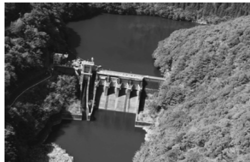
図 2.3-2 平鍋ダム全景(被災前).
