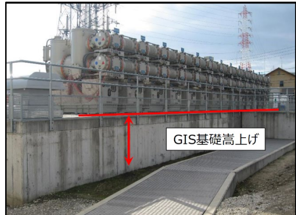
図 3.1.1.4-2 機器基礎嵩上げ.
