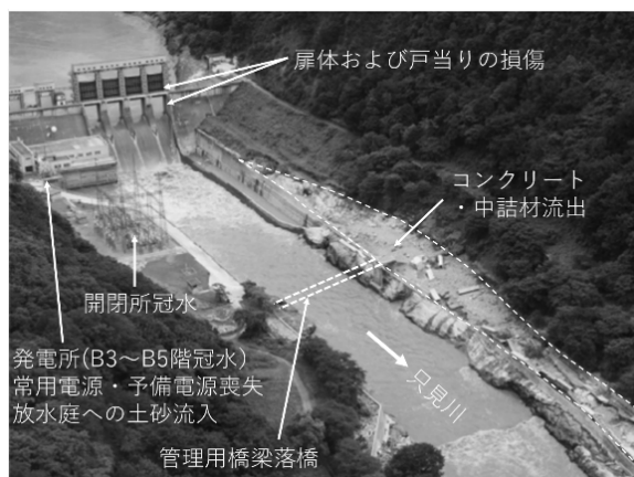
図 2.4.3-4 滝発電所下流の被害状況。
