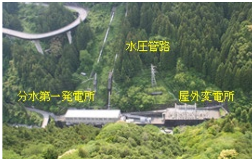
図 3.1.2.1-1 工事前の発電所全景。
