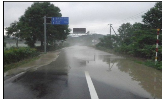
写真 4.3.3.3-2 国道 275 号線冠水
