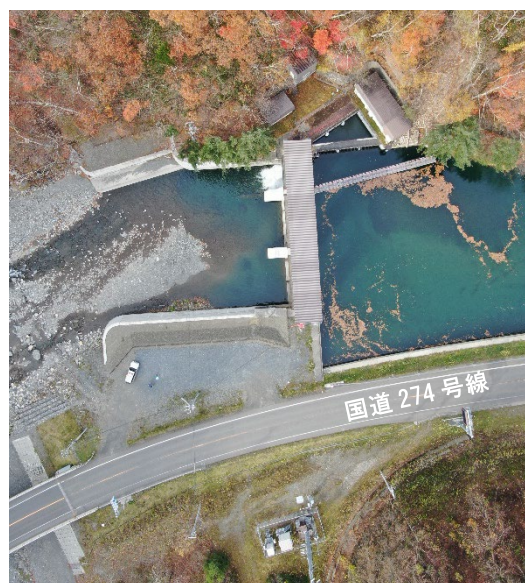
図 2.6.3-2 沙流川取水堰復旧状況。
