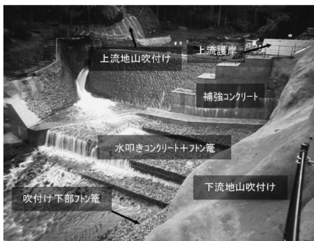
図 2.2-2 仮復旧対策全景.
