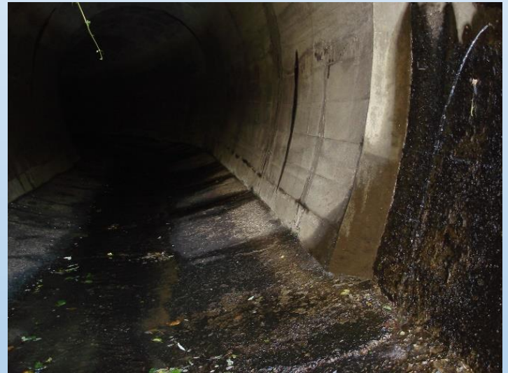
陥没地点の水路内部(変状なし)
