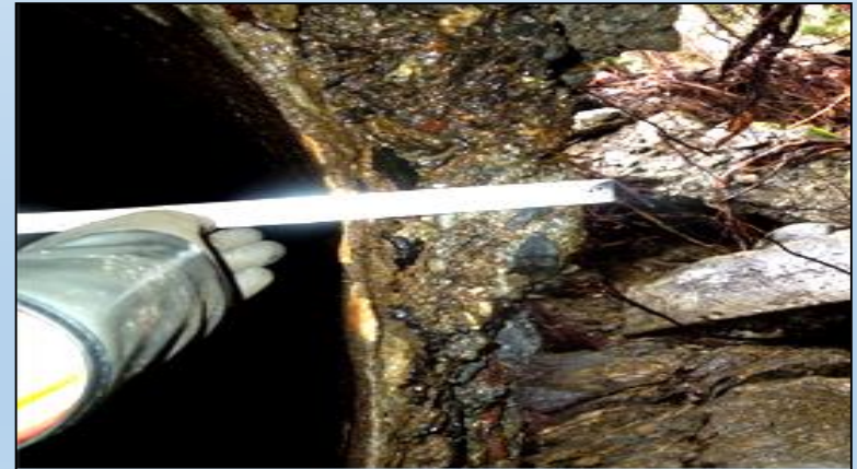
写真 6.5.2 既設覆工厚状況
