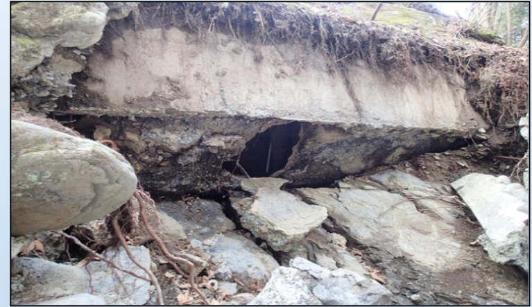
写真 6.5.4 同左（正面より）
