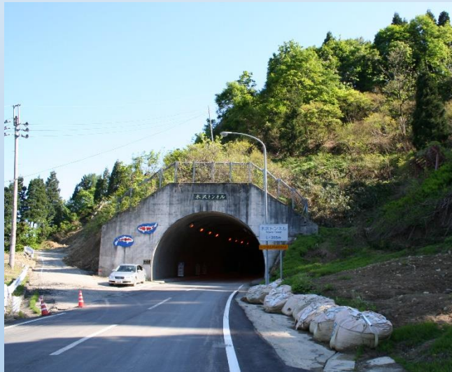
木沢トンネル坑口
