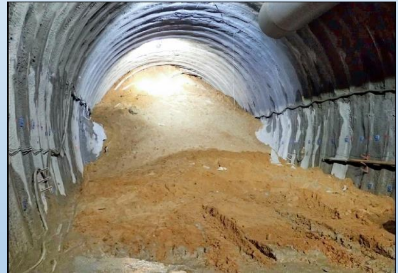
トンネル内部の状況
