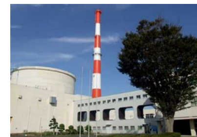
高速実験炉「常陽」
