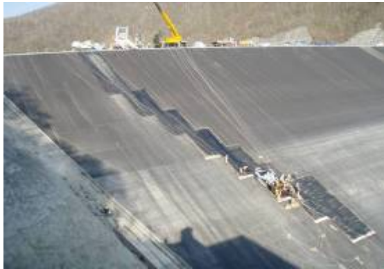
◆舗設施工状況全景
