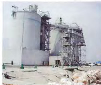
1号埠頭 石炭灰船積設備
