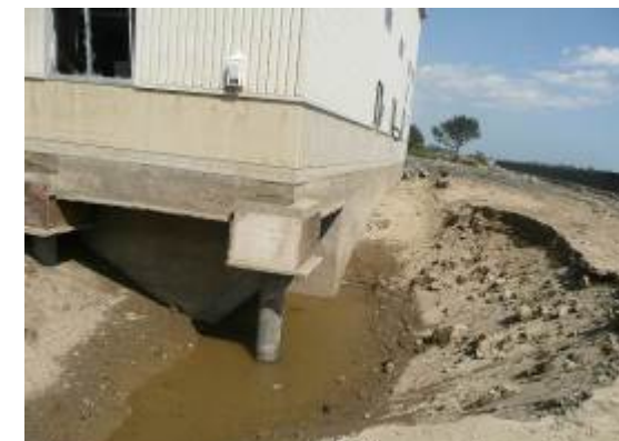
写真-4 貝処理建屋基礎洗堀状況
