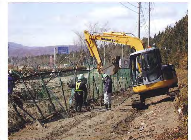
発電所外周のフェンス復旧作業
