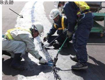
②クラック充填（ゴム化アスファルト）
