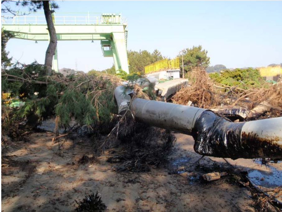
P18-03-01 (第1分水池南側) パイプライン配管部破断 (構内平面図の紫色の線が配管)
