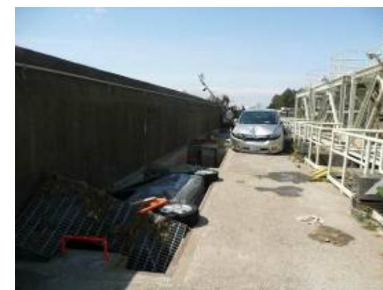
写真-5 取水口除塵機付近ガレキ状況
