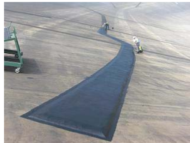
⑧表面保護材塗布完了（三層塗）→復旧完了
