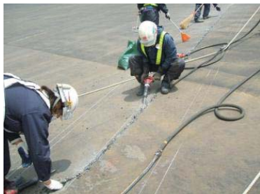
①クラック開削（U字カット）
