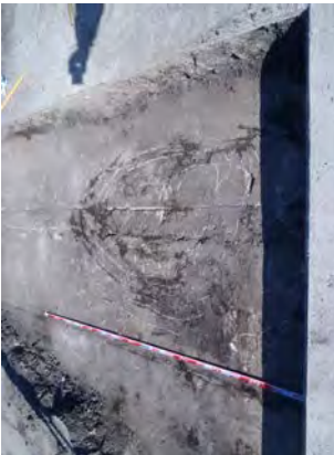
撮影2011.01.18 (桁上部の損傷)
