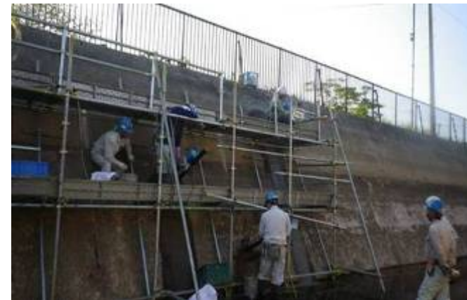
開水路側壁を固定するためのロックボルトを打設し、平成23年6月26日運転再開
