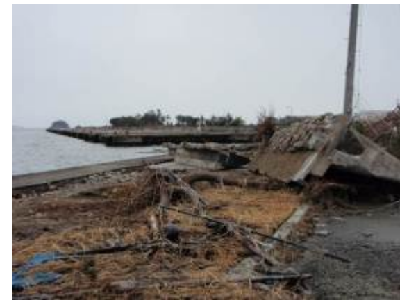
写真-3 防潮堤被災状況
