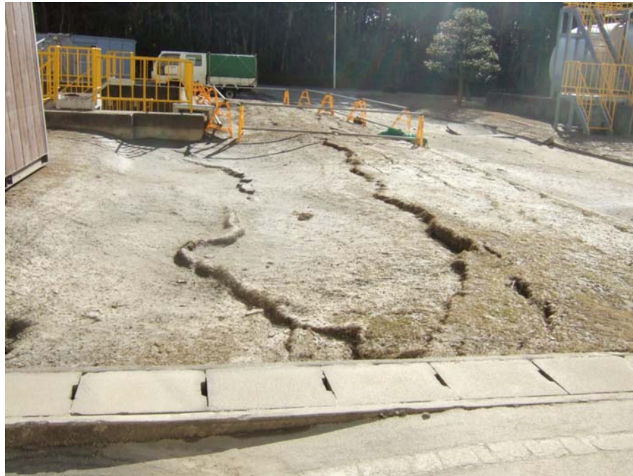
P09-01 (灰流水調整池〔海側〕の北側の緑地) 地震による地割れ発生 液状化も発生している
