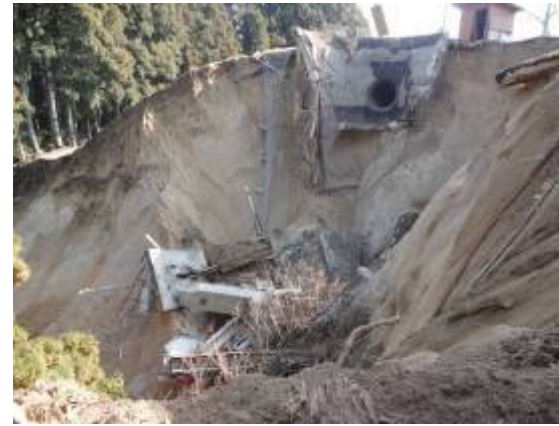
①水槽状況（上流より）
