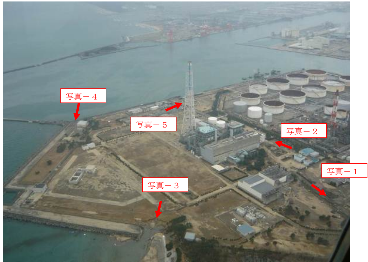
震災状況 (平成23年3月15日撮影)
