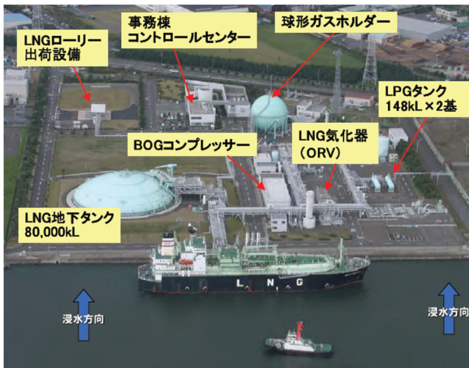
図-2.5.3 仙台市ガス局港工場の津波被害
