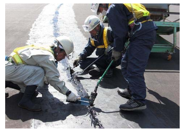
◆開削部ゴム化アスファルト充填
