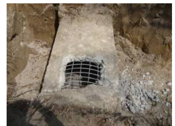
花貫川第二発電所 被害状況写真
