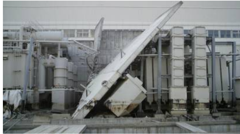
写真-1 1号機側 防火壁倒壊状況
