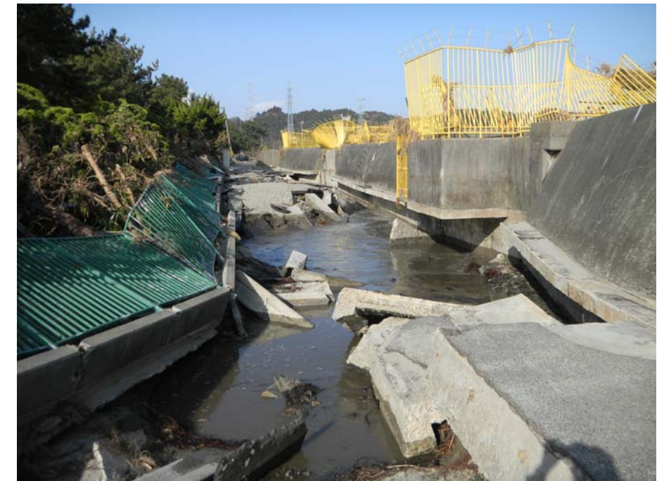
P11-01 (第1分水池南側付近 写真右側が海) 防潮堤背面道路の路面陥没と防潮堤倒壊、 防潮堤下部は基礎の手当が不十分であった模様
