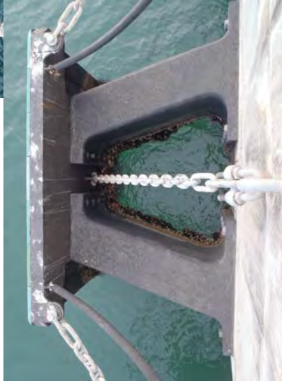
(BL22防舷材を取り外して設置した)
