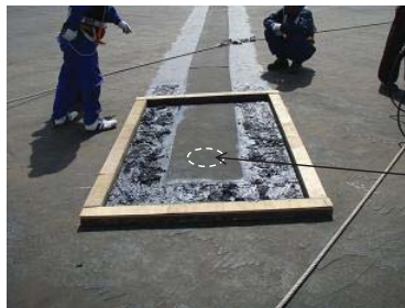
④アスファルト舗設準備
