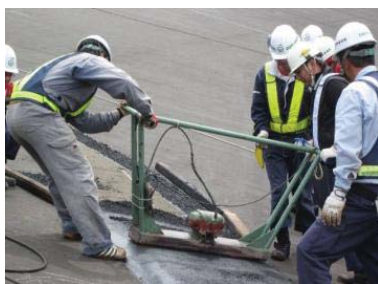
⑤アスファルト舗設（人力転圧）
