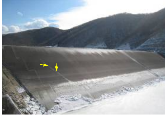
◆八汐ダム左岸ひび割れ状況
