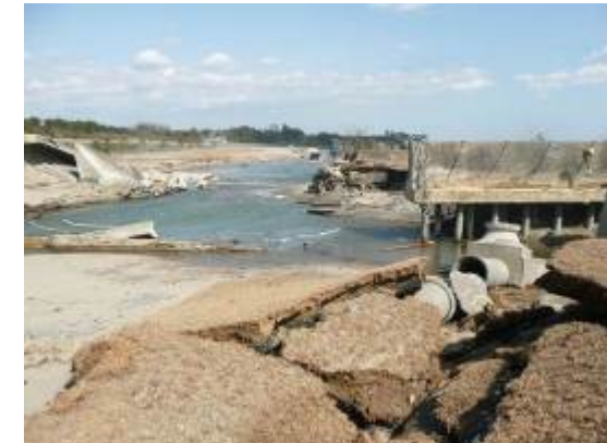
写真-3 敷地護岸洗堀状況
