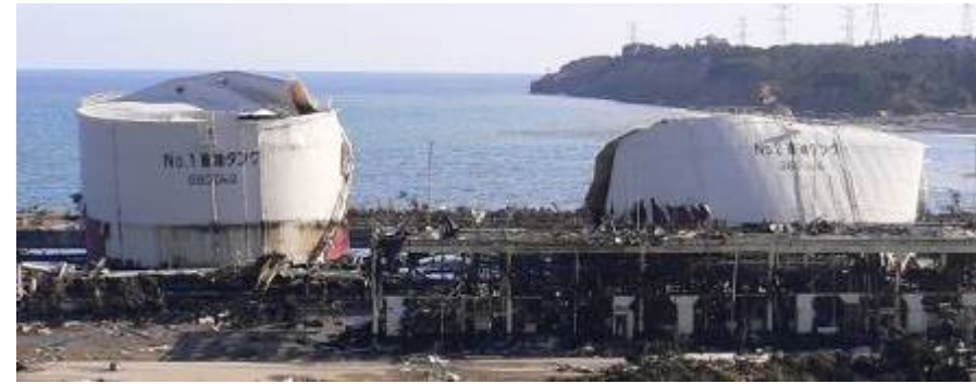
写真-7 重油タンク被災状況
