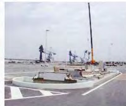
全壊した5号埠頭警備室
