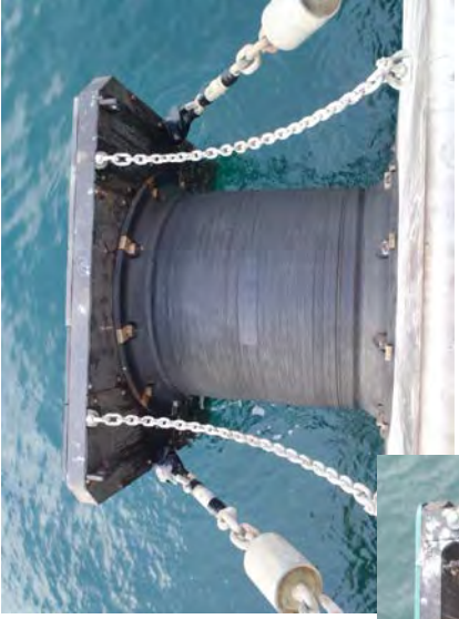
(BL12防舷材を取り外して設置した)
