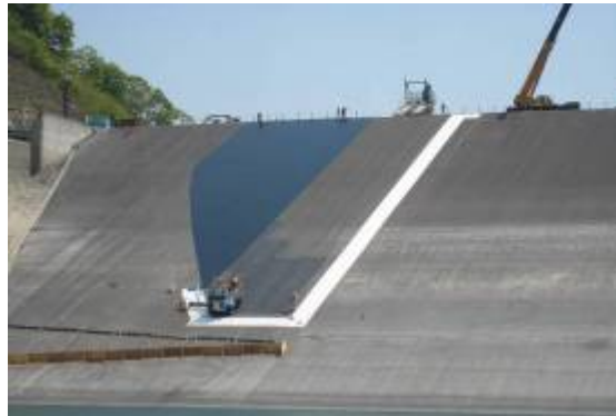
◆表面保護層施工状況全景
