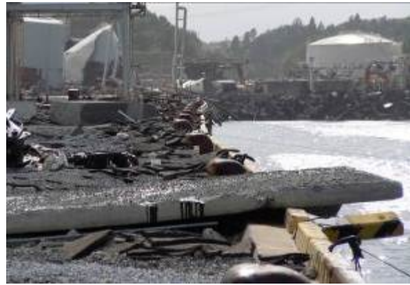
写真-3 荷役岸壁被災状況
