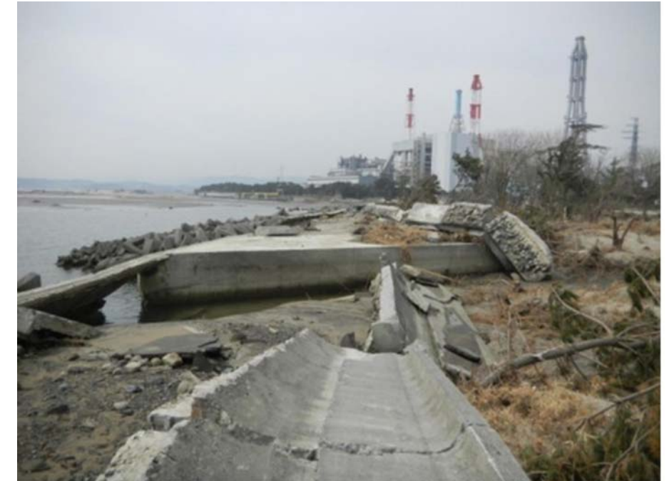
P20-05 (勿来第2開閉所の脇) 防潮堤倒壊 (写真中、遠方に見える赤白煙突のうち右側が6号、左側が7号)
