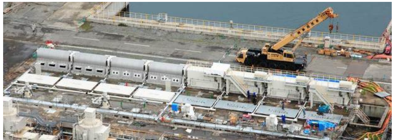
除塵機復旧状況
