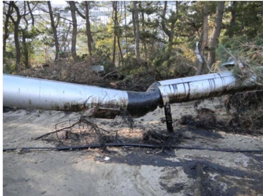
P18-03-02 (第1分水池南側) パイプライン配管部破断 (構内平面図の紫色の線が配管)
