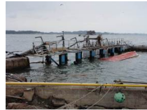
写真-2 取水口スクリーン他 被災状況
