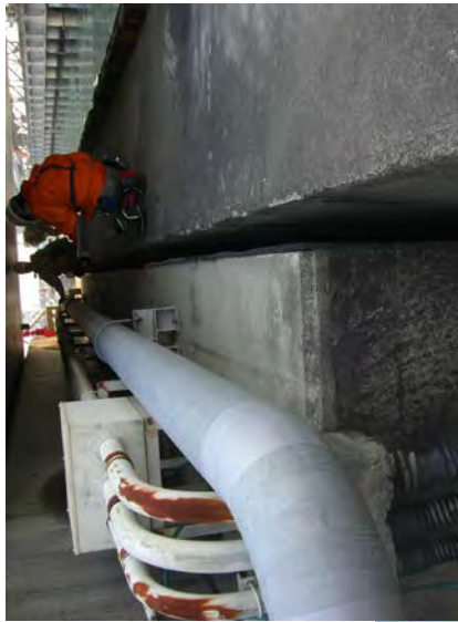
ex) No.1連絡橋橋台部
