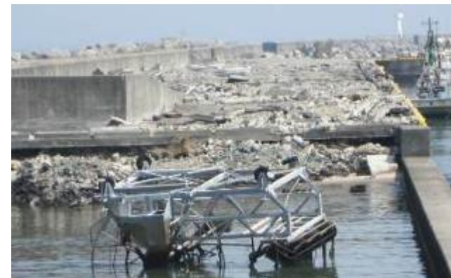
写真-9 タグボート岸壁被災状況
