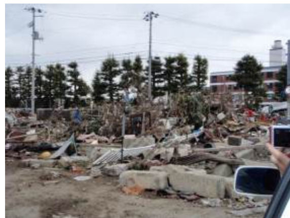
写真-1 発電所入口ガレキ散乱状況
