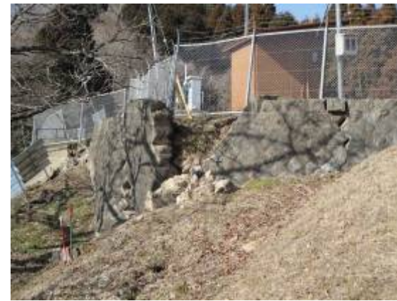
③水槽石積崩壊
