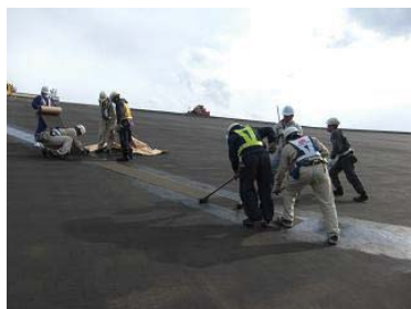
③シート敷設（特殊アスファルト＋不織布）
