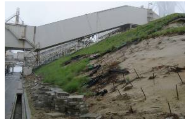
写真-8 構内法面被災状況
