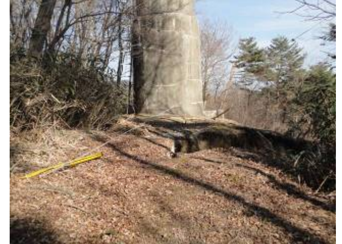
②水路管側から見たサージタンク 手前の水路管が破損し流出水が地山土砂を押し流した
