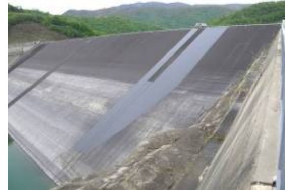
右岸側 施工完了状況
