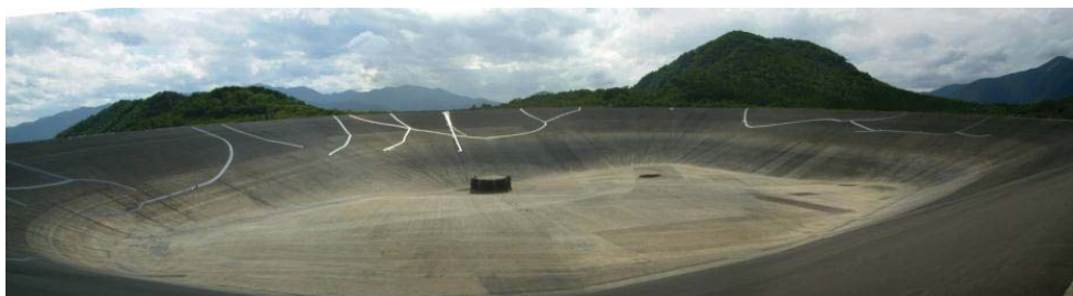
補修完了後の沼原ダム (2011年6月24日)
