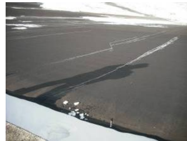
◆クラック発生状況 (補修前)
