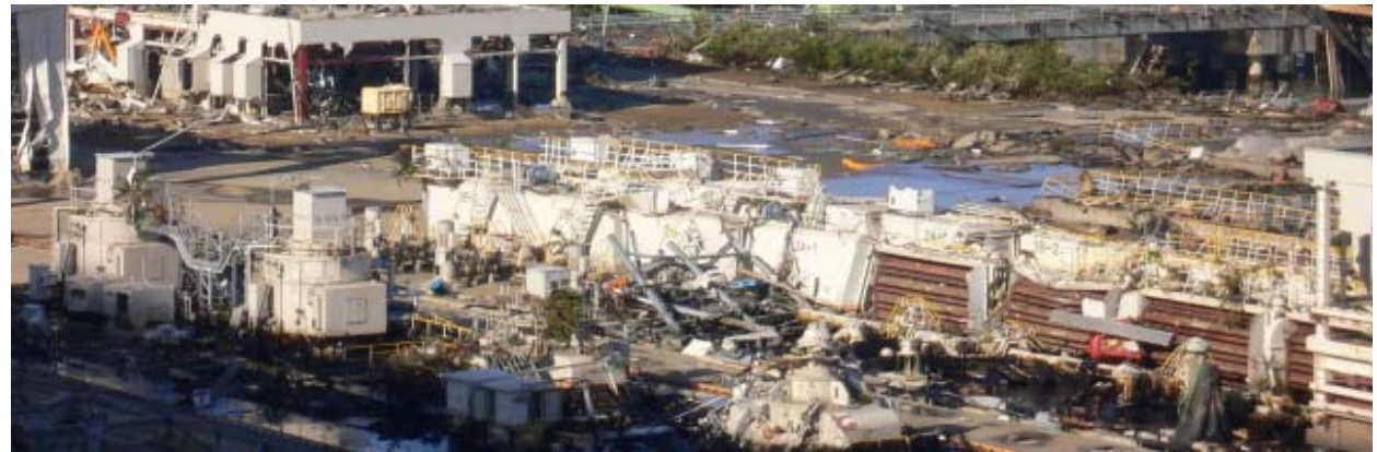
写真-2 除塵機被災状況
