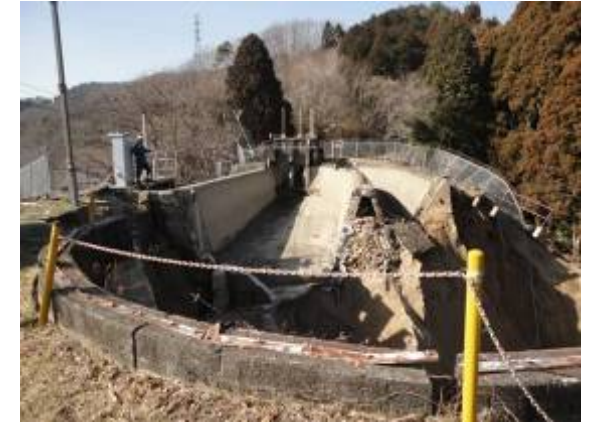
②水槽状況（下流より）
