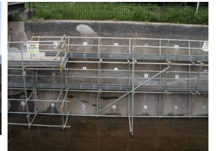
開水路側壁を固定するためのロックボルトを打設し、平成23年6月26日運転再開
