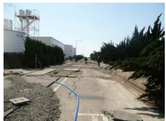
写真-2 構内道路被災状況
