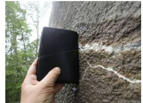
③上記サージタンクの既存ヘアクラックが地震により開口し（推定）、通水時に漏水が発生
