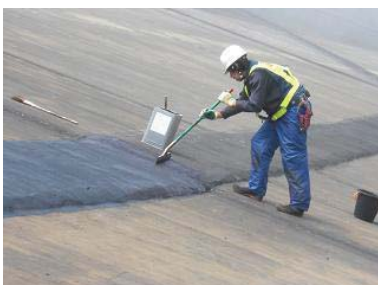
⑦表面保護材塗布（アスファルト乳剤）
