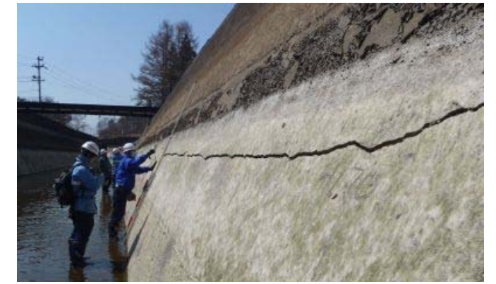
◆側壁が水路外側へ倒れ込んだことにより発生した曲げ引っ張りひび割れ（幅2cm）
