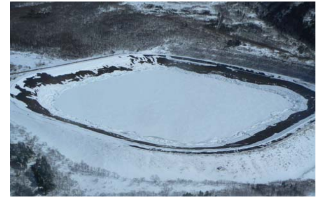
◆被災直後の調整池全景 (H23年3月12日)
