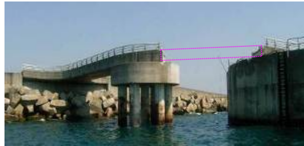
写真-4 放水口連絡橋被災状況
