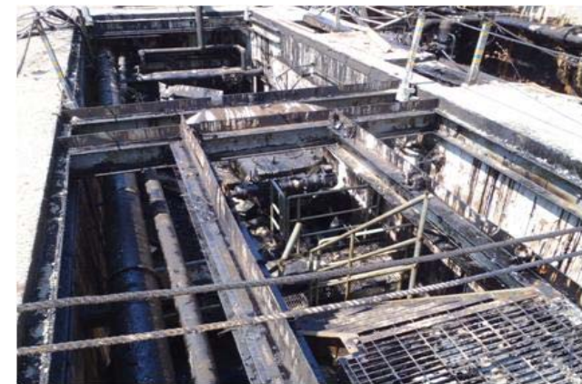
写真-6 取水口ポンプ室被災状況
