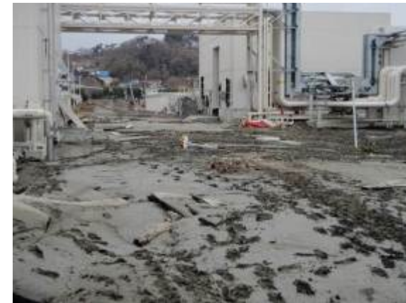
写真-4 構内土砂堆積・道路洗掘状況
