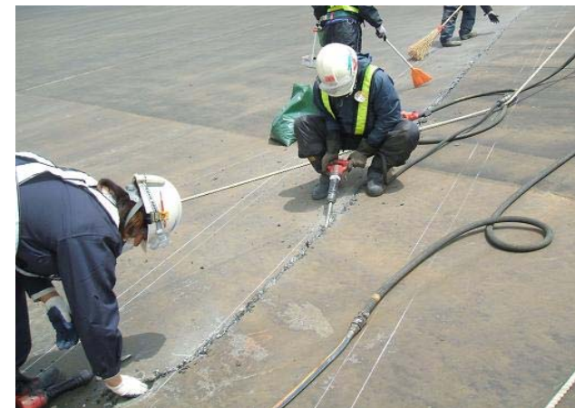
◆クラック頭部のはつり状況
