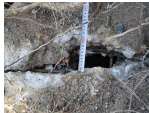
④地震時の水路管の破損
