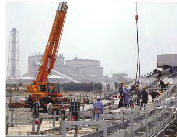
5号埠頭 ベルトコンベア周辺 復旧作業
