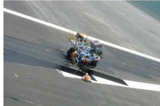
◆表面保護層施工状況
