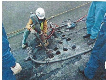
試験施工におけるコア採取状況
