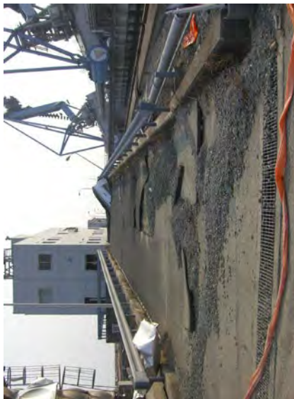
ex) No.2連絡橋進入路 EPS路体部分の破壊が生じていた
