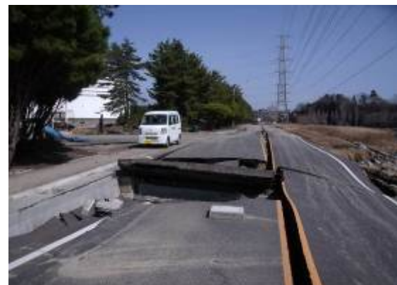
写真-1 発電所進入路被災状況
