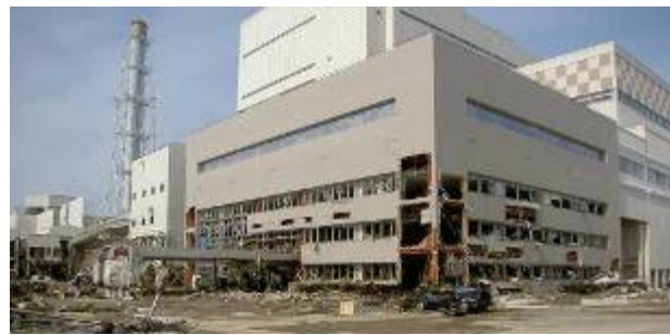
写真-5 サービスビル被災状況
