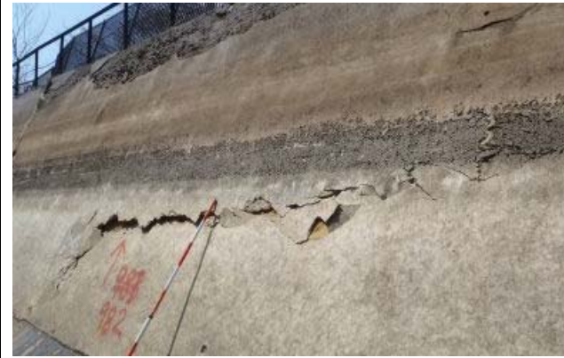
◆側壁が水路内側へ倒れ込んだことにより発生した圧縮ひび割れ
