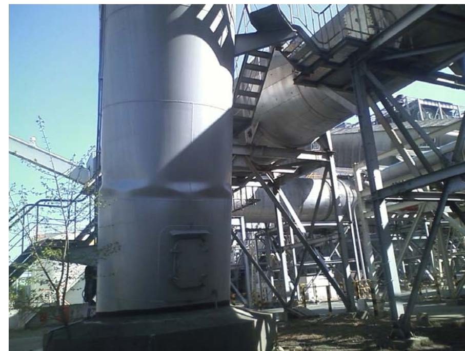
P15-01 (6号煙突脚部座屈) 3脚のうちの1脚
