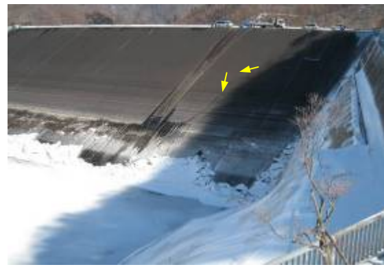
◆八汐ダム右岸ひび割れ状況
