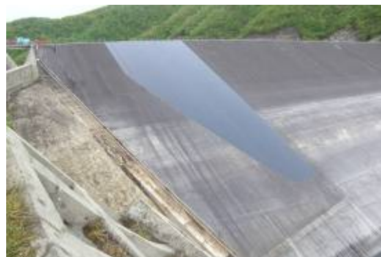
左岸側 施工完了状況
