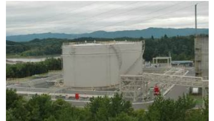
軽油タンク高台へ移動 復旧状況
