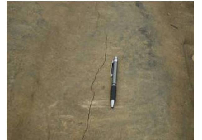
◆クラック詳細 (補修前)
