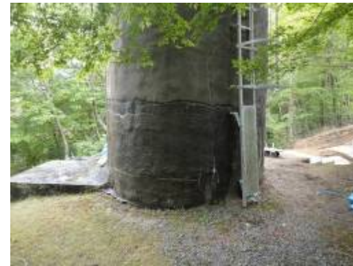
③上記サージタンクの既存ヘアクラックが地震により開口し（推定）、通水時に漏水が発生
