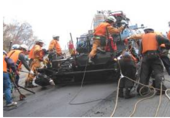
◆舗設施工状況
