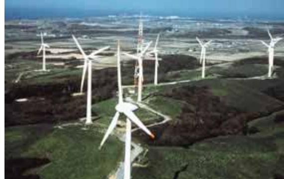
苫前ウィンピラ発電所（北海道苫前町） 30,600kW（1,650kW×14基、1,500kW×5基）
