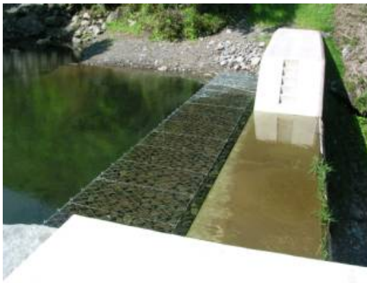
(a) 浸透取水方式(フトン籠)
