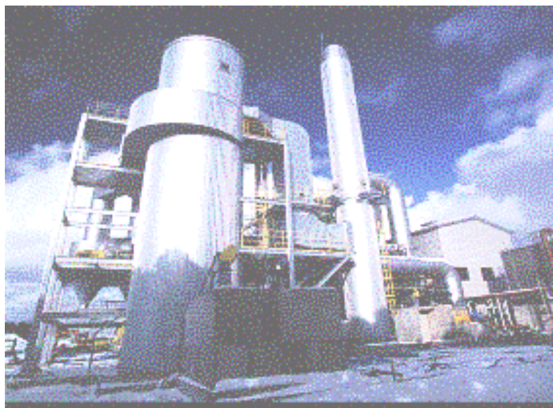
図 2. 6-1 能代バイオマス発電所の外観
