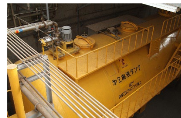
有姿廃棄物(タンク等の内部)にセメントなどを充填 Large Components
