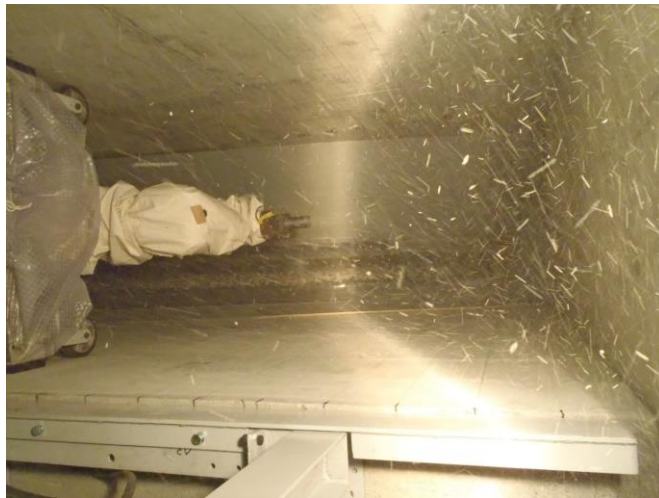
ロボットによる吹付
