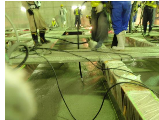
バイブレータ使用状況
