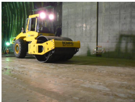
大型振動ローラにより転圧
