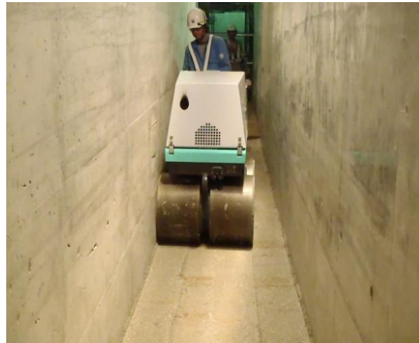
小型振動ローラによる振動転圧
