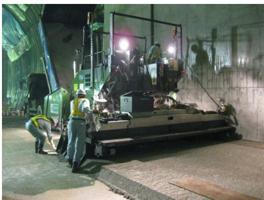
アスファルトフィニッシャーにより敷均し
