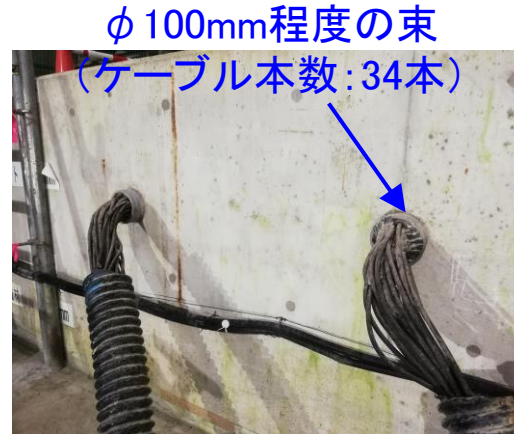
実規模施設に設置した既存計測器のケーブルの束
