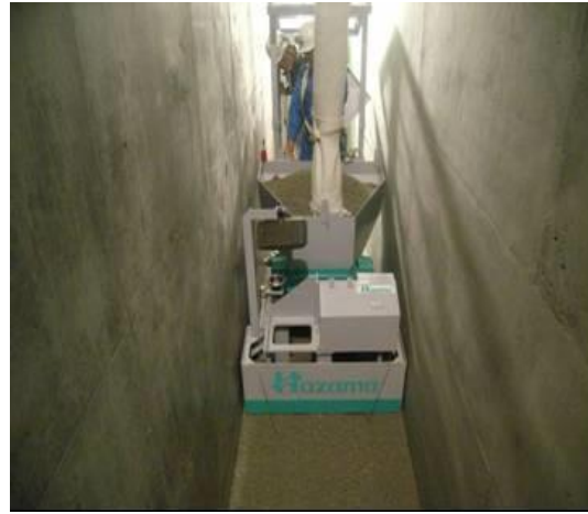
敷均し機械による敷均し
