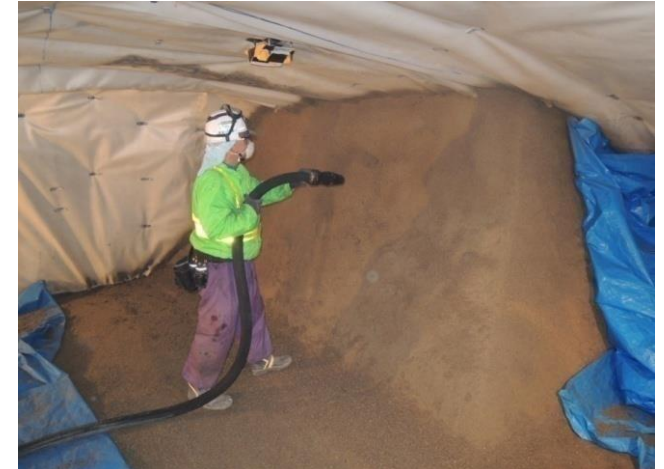
吹付け機による吹付け
