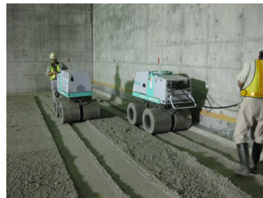
端部は小型振動ローラにより転圧
