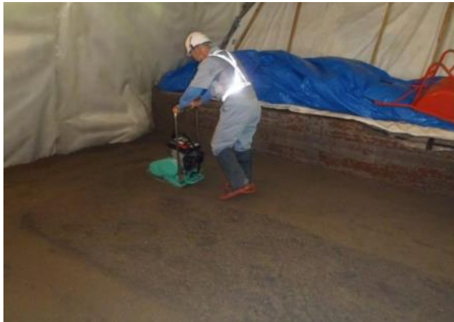
プレートコンパクタ(60kg)による予備転圧
