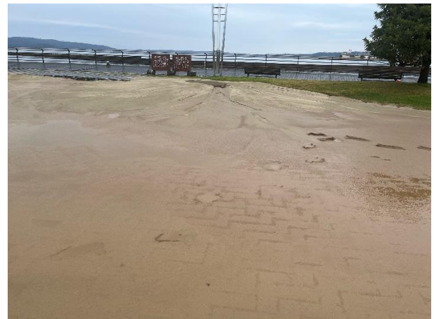
写真-1 七尾港における噴砂
