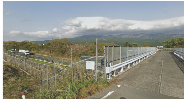
図-11 現地の状況写真（東名高速道路；溶岩流横過地点付近）
