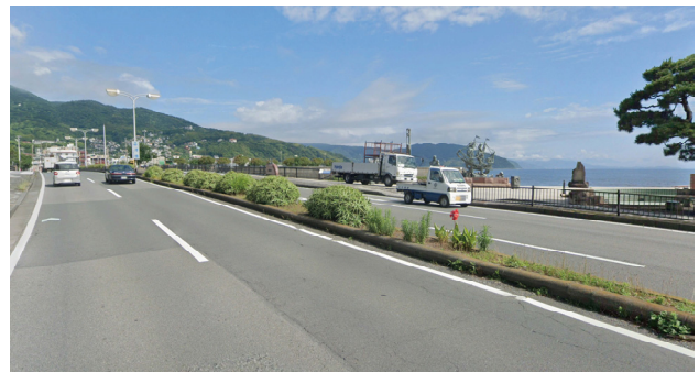
図-13 現地の状況写真（国道135号；地震津波浸水地点付近）
