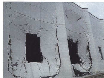
2011年東北地方太平洋沖地震における浄化センターの被害 (写真：仙台市建設局)
