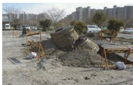
2011年東北地方太平洋沖地震における耐震性貯水槽の浮上被害
