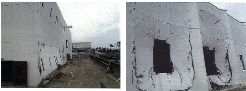
仙台市南蒲生浄化センターのポンプ室、ならびに曝気槽送風機室の津波損傷の事例 (仙台市建設局)
