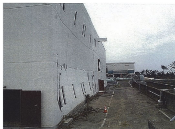
2011年東北地方太平洋沖地震における浄化センターの被害 (写真：仙台市建設局)
