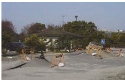
2011年東北地方太平洋沖地震における耐震性貯水槽の浮上被害
