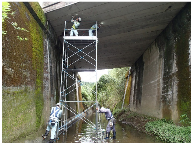
移動式足場 (ローリングタワー)
