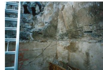
ケーソン基礎頂版下のコンクリートにひび割れが発生した。
