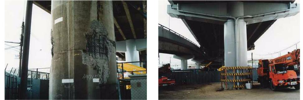
昭和57年浦河沖地震の経験をもとに、順次1) 主鉄筋段落し部に関する震災点検、2) 試験工事(平成6年完工、写真のとおり)が実施された。3) さらに本格工事を進めていくその矢先に地震が発生した。
