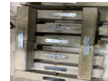
・連結補強した擁壁
