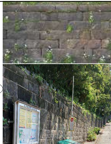
写真-1 山手地区のブラフ擁壁
