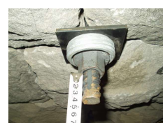
支圧プレート類の締結
