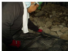
支圧アンカーの設置
