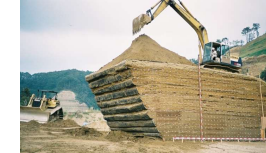
逆勾配補強盛土の施工実験
