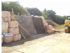
完成状況（ネットに覆っている側がジオテキ）
