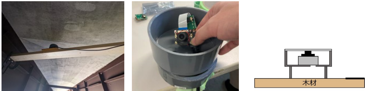
図-4.4.3 RC 床版下面のひび割れ撮影用カメラの設置状況
