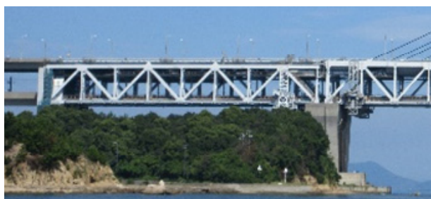
写真-4.1.16.1 対象橋梁
