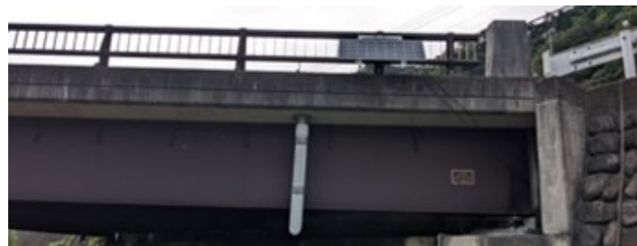
写真-4.4.6 太陽光パネルの設置状況 (G6 桁側)
