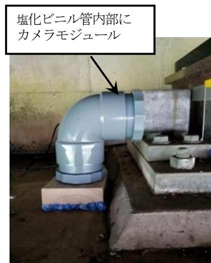
写真-4.4.8 A1側G3桁のカメラモジュール設置状況
