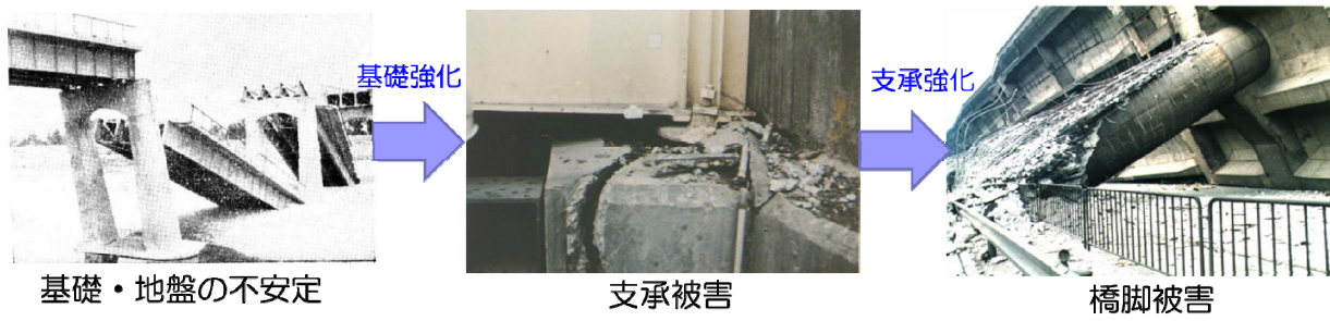
図-2.3.2 地震による構造部材の損傷部位の変化
