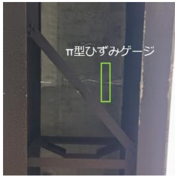
写真-4.4.3 A橋のRC床版下面の状況
