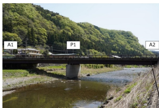
写真-4.4.2 A橋の全景（側面）
