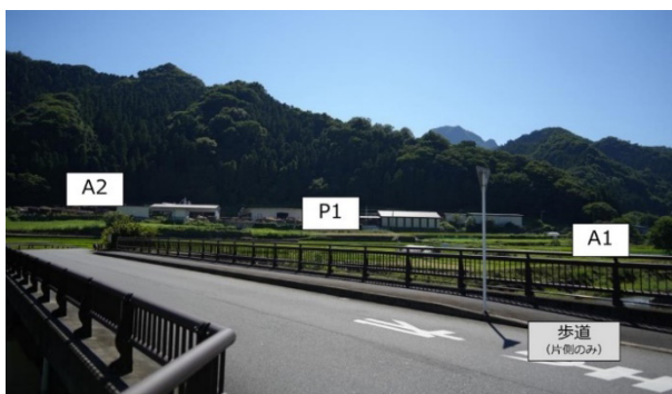
写真-4.4.1 A橋の全景（橋面）
