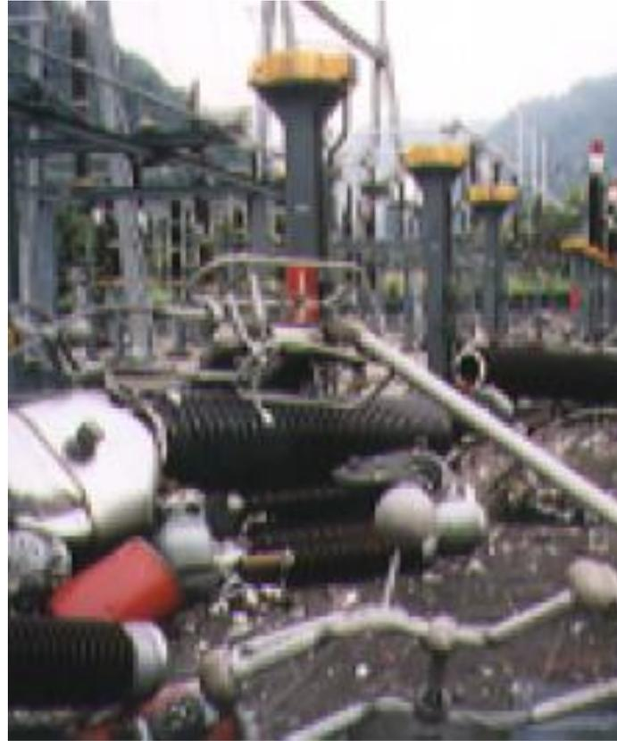
空気遮断機の破壊
