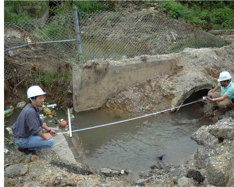
下水道管の破断
