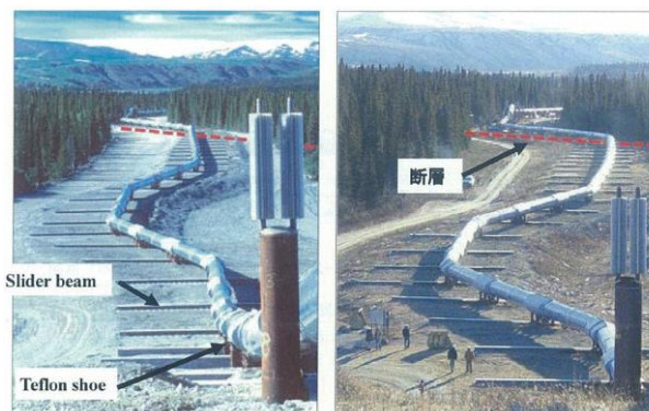
図 2-2-2 アラスカ横断石油パイプラインの活断層対策 (Nyman et al. (2014)に加筆) (左:地震前, 右:地震後, 赤の破線は断層)
