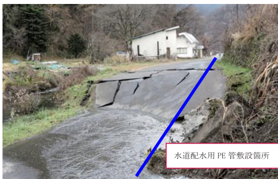
写真 2-3-1 塩島地区地表変位 (垂直変位約 80cm)
