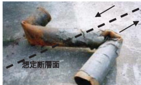
図 1-5-6 断層による管路被害（台湾集集地震 25) ）
