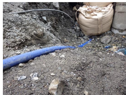
写真 2-3-2 掘削時に確認できた 旧地表面の変位
