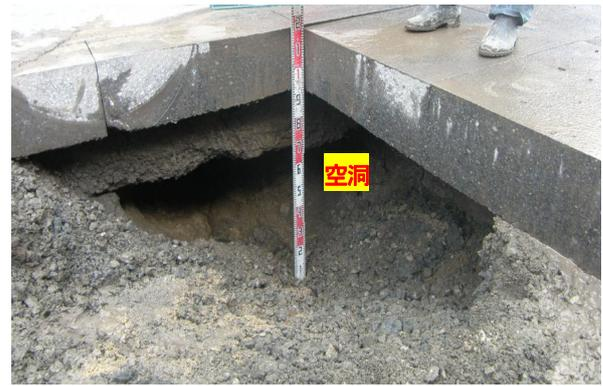
写真-1 液状化によって発生した空洞
