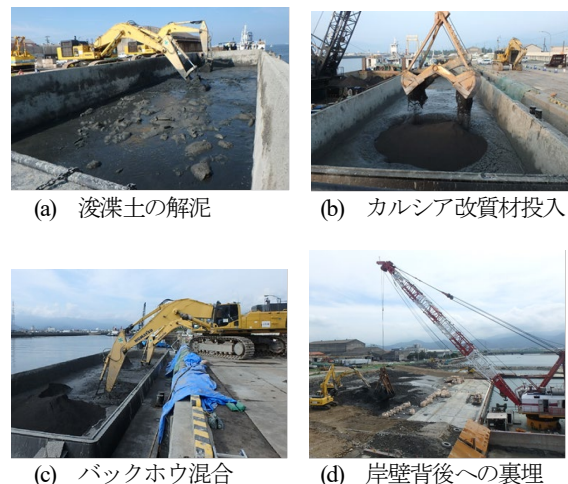
図-7 カルシア改質土の施工状況
