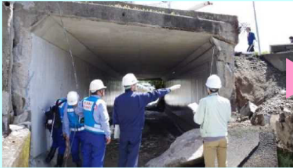
道路施設の被害調査
