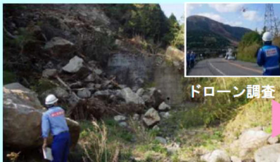
土石流危険渓流の点検
