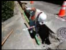
従来手法による埋設深さの計測
