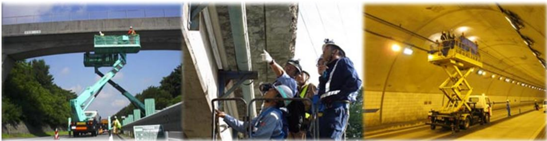
近接目視点検
