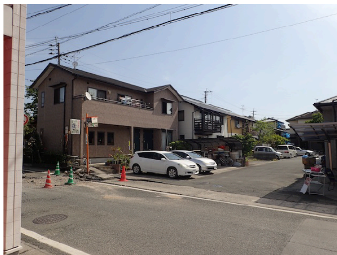
図 3.2-1 2016年熊本地震の益城町中心部の地表地震断層近傍の様子
