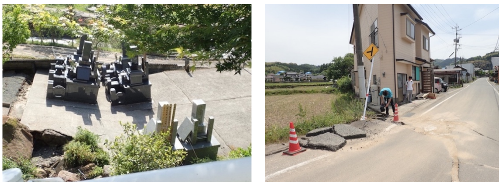
図 3.2-3 2016 年熊本地震本震による地表地震断層ごく近傍の様子
