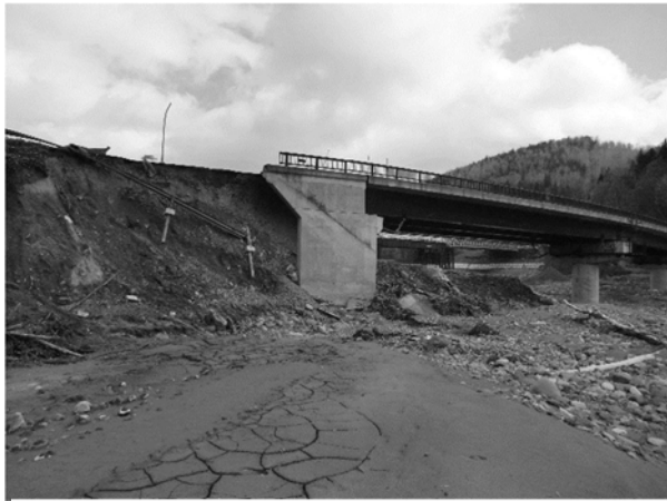
(a) A-2 橋台背面盛土の流失
