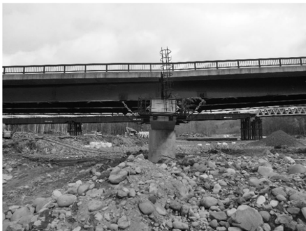
(c) P-2 橋脚の沈下
