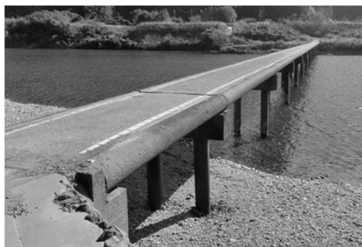
写真-2.1.1 沈下橋（高知県，三里沈下橋）
