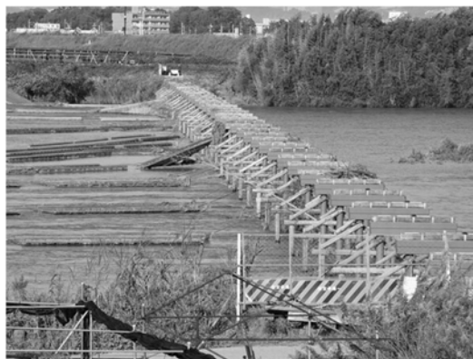
写真-2.1.3 洪水により流出した流れ橋（台風19号による被害2019年） 2.1.19)
