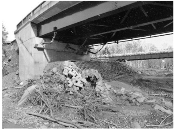
(b) A-2 橋台護岸の被害
