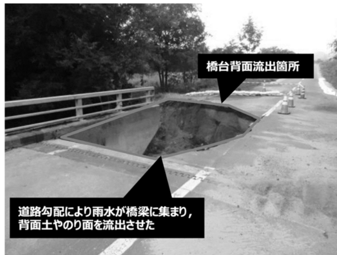
図-2.2.7 川上橋の被災状況（右岸側） 22,3)
