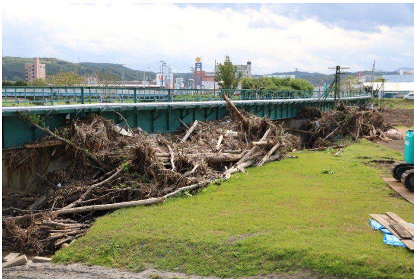
写真-2.1.4 洪水後の流木等の堆積状況
