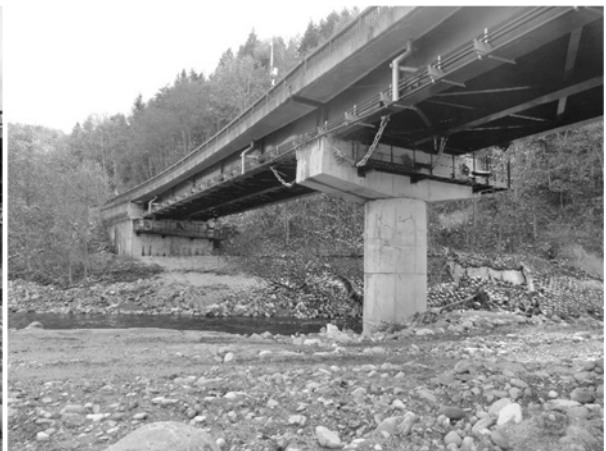
(d) P-1 橋脚と A-1 橋台
