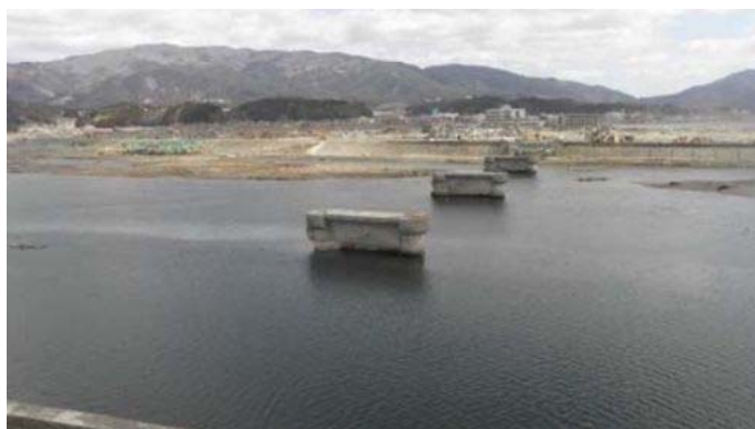
図-1.1.1 姉齒橋・上部構造流出状況
