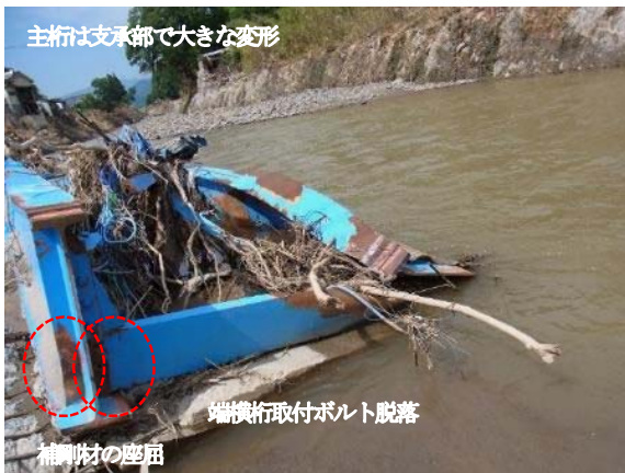
図-1.2.90 桁の損傷状況 [出典：佐藤]
