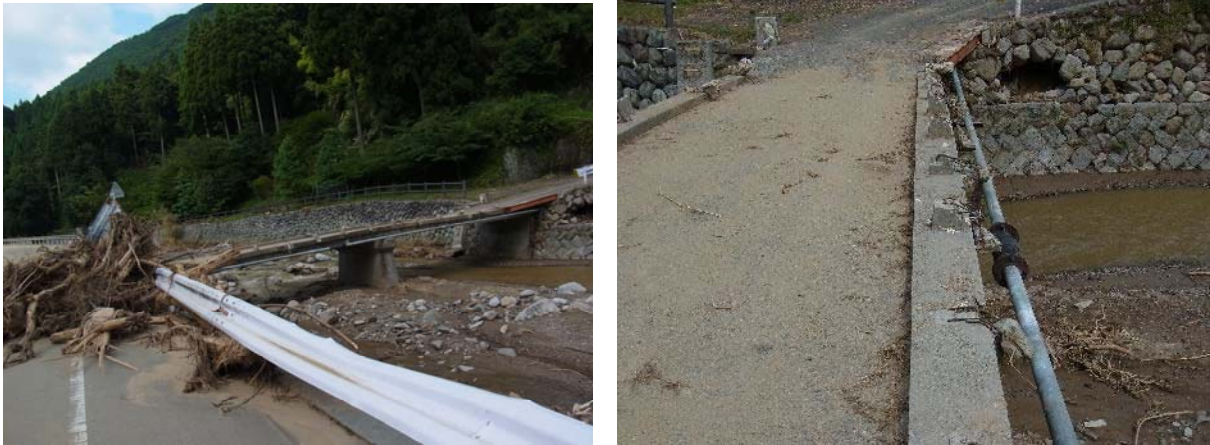
図-1.2.84 小石原鼓周辺の橋梁の損傷状況 [出典：佐藤]
