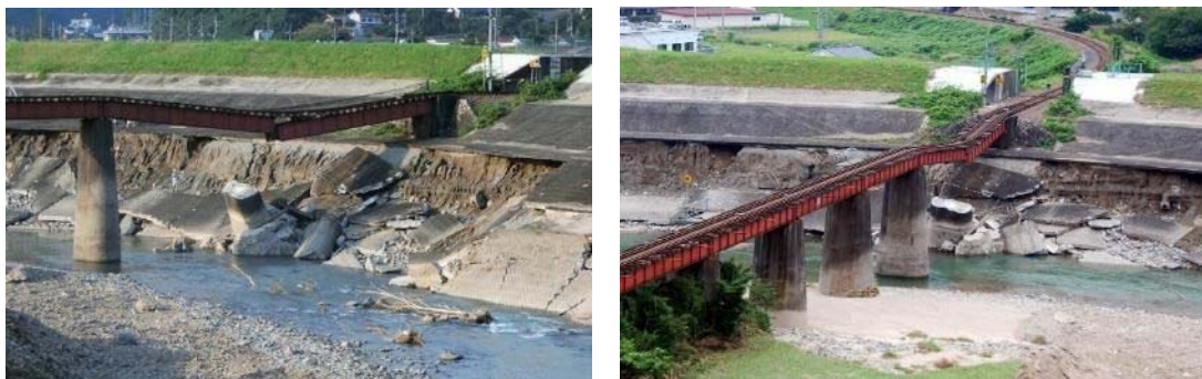
図-1.2.63 井原川橋梁(JR西日本三江線) 橋脚1基流出
