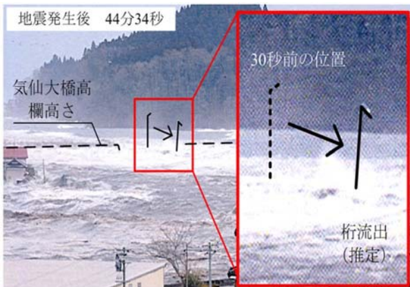
図-2.2.47 気仙大橋が流出したと推定される瞬間
