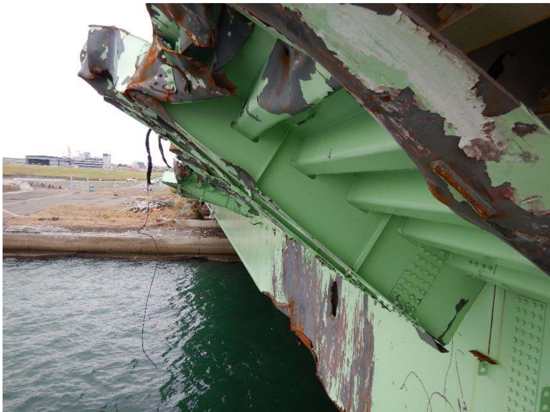
図-1.3.5 関西国際空港連絡橋の側面損傷状況 [出典：伊津野]
