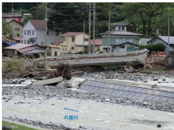
図-1.2.81 日陰橋 落橋
