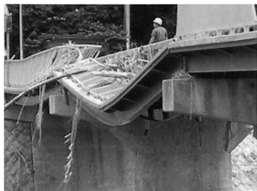
図-1.2.31 河野原橋 歩道橋鋼製桁の変形
