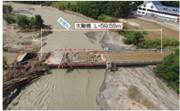
図-1.2.78 大鮎橋 落橋
