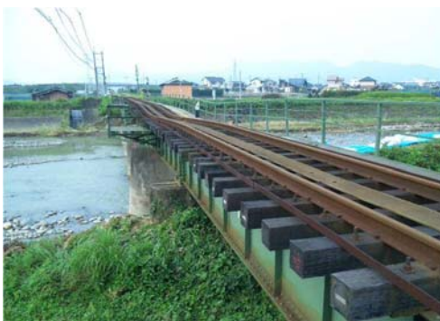
図-1.2.57 隈上川橋梁(JR九州久大線) 橋脚沈下
