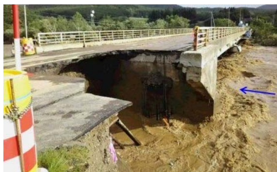
図-1.2.74 太平橋(国道38号線) 橋台背面の洗掘
