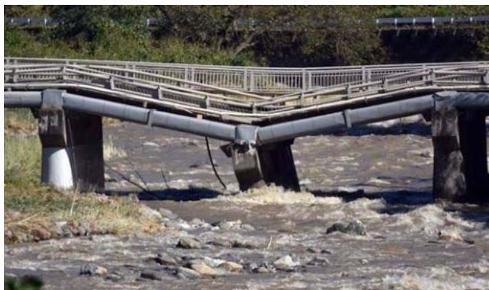
図-1.2.104 法雲寺橋(国道20号線) 橋脚沈下
