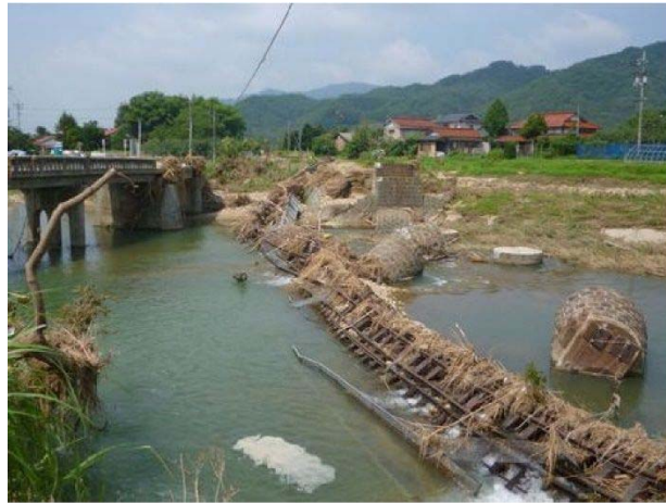
図-1.2.60 第6阿武川橋梁 流失
