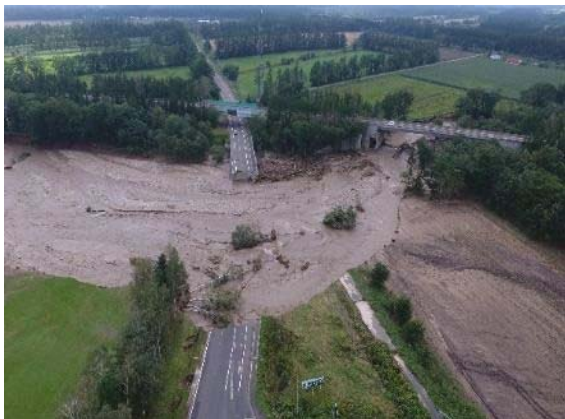
図-1.2.79 小林橋(小林川) 落橋
