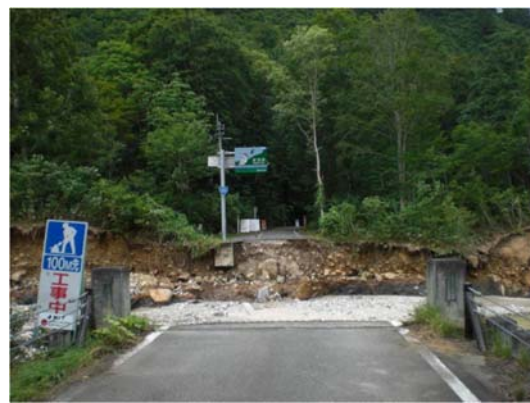
図-1.2.49 金泉橋（只見川 魚沼市）流失
