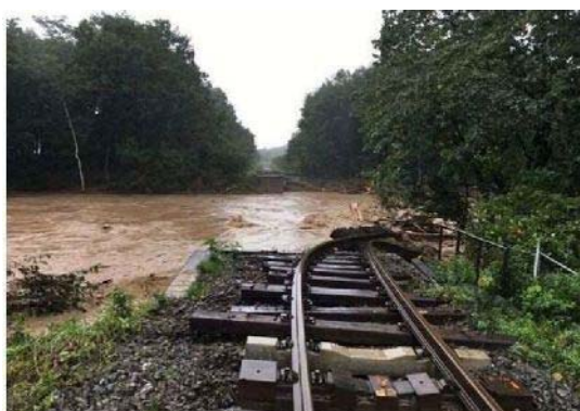
根室線 第1佐幌川橋梁 橋梁流失
