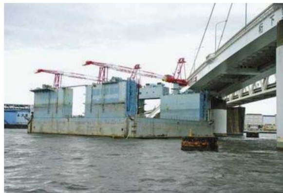
図-1.3.9 大黒大橋の損傷
