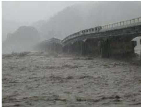
図-1.2.4 竜西橋 陥没
