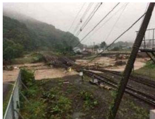
根室線 下新得川橋梁 橋梁流失
