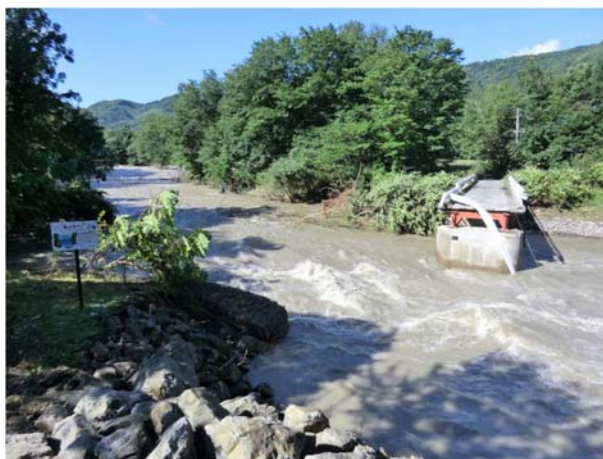
図-1.2.73 武利橋(町道) 落橋
