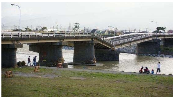
図-1.2.27 十文字橋 洗掘による沈下
