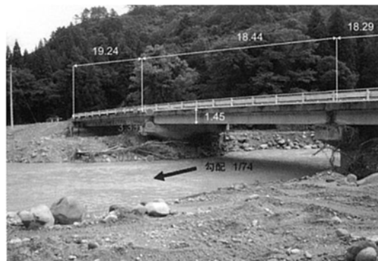
図-1.2.40 中ノ平橋（蒲生川 滝ダム上流 南会津群只見町） 洗掘による取り付け道路の流出
