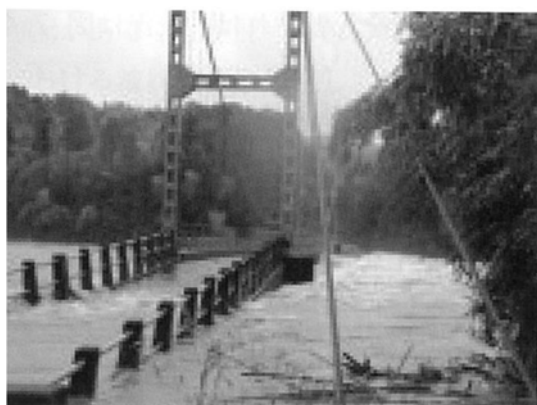
図-1.2.25 久住橋 崩壊直前
