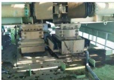
写真③ P2支承の状況
