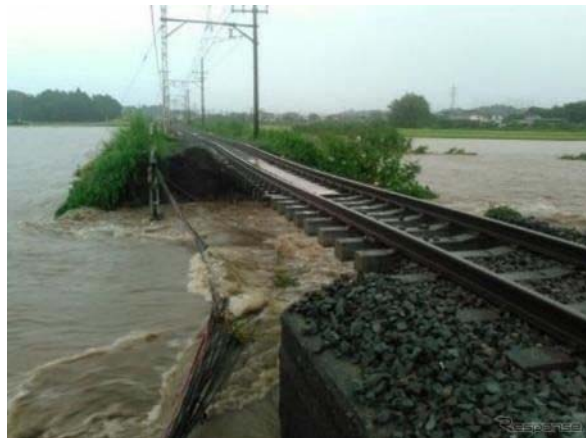
図-1.2.70 姿川第二避溢橋梁 橋台と橋桁流失
