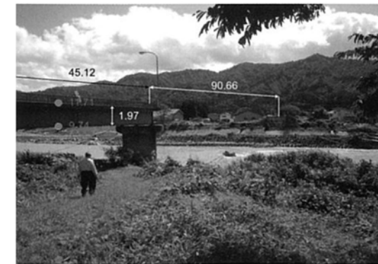
図-1.2.46 小川橋（伊南川 滝ダム上流 南会津群只見町）橋脚の倒壊による流失
