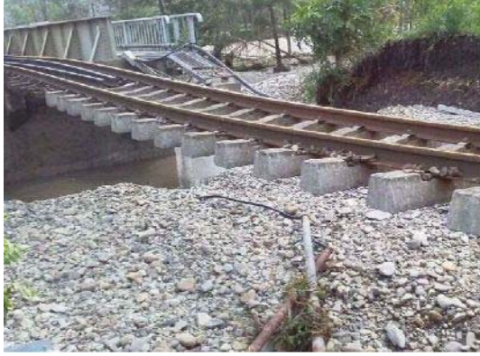
根室線 芽室川橋梁 路盤流失
