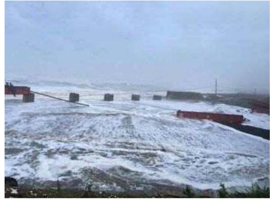
日高線 慶能舞橋梁 橋梁流失
