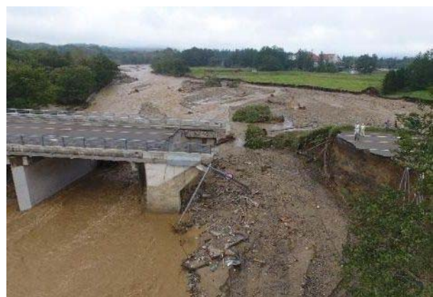
図-1.2.80 清見橋(ペケレベツ川) 洗掘による傾斜, 沈下
