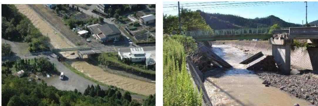
図-1.2.65 鳴滝橋(国道162号線) 落橋
