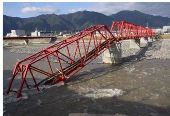
図-1.2.109 千曲川橋(上田電鉄別所線) 一部落橋
