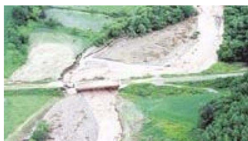
図-1.2.9 栄進橋 橋台洗掘, 護岸
