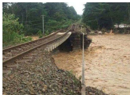
根室線 清水川橋梁 橋梁流失
