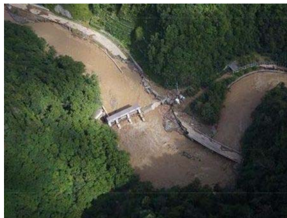
図-1.2.76 ニセクシュマナイ橋 橋台背面の洗掘
