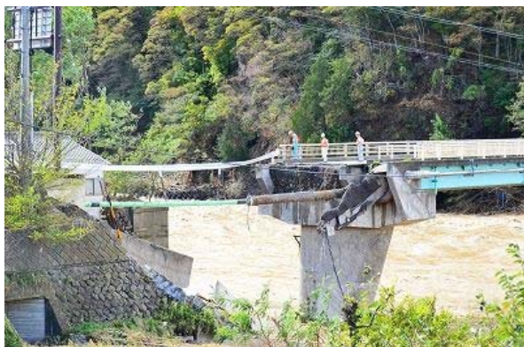
図-1.2.106 田中橋 一部落橋
