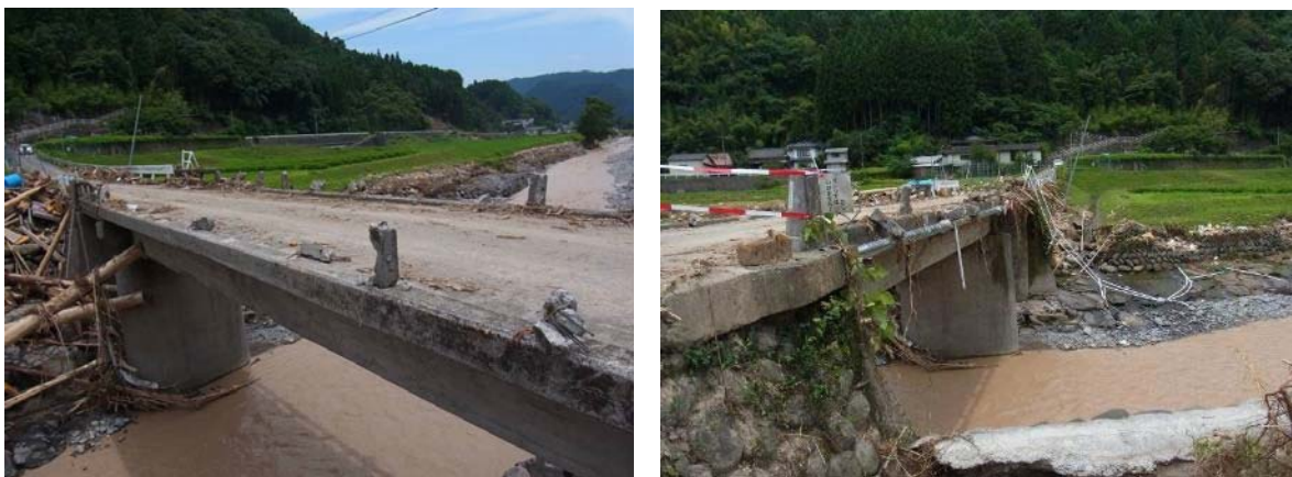
図-1.2.85 西河内橋の損傷状況 [出典：佐藤]
