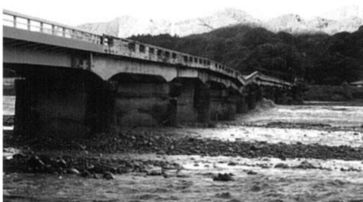
図-1.2.7 滝西橋 河床の洗掘により橋脚沈下
