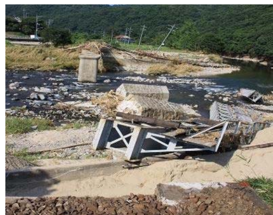
図-1.2.94 第一三条川橋梁 (JR 芸備線) 落橋 [出典：幸左]
