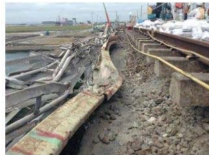
写真② バラスト止めの損傷
