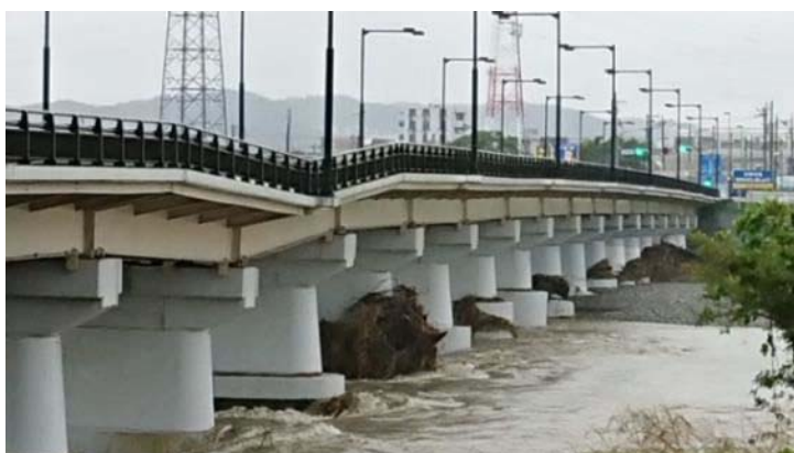
図-1.2.103 日野橋 橋脚の沈下
