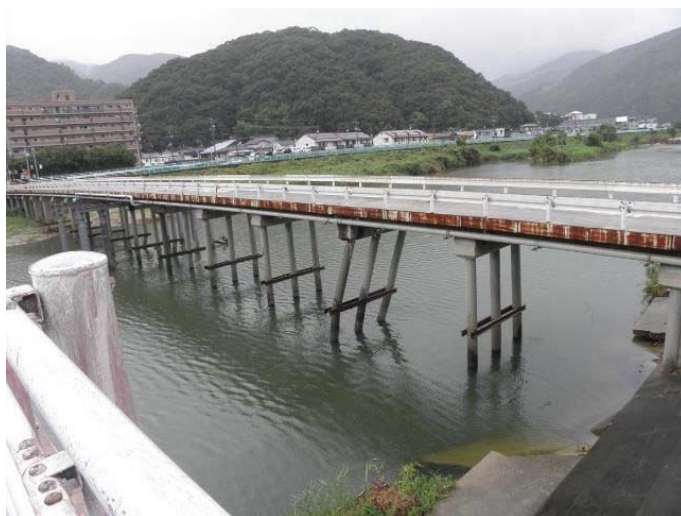
図-1.2.97 大広橋 橋脚傾斜 [出典：幸左]
