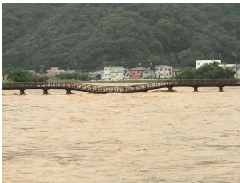
図-1.2.99 真光寺橋 流出前の状況
