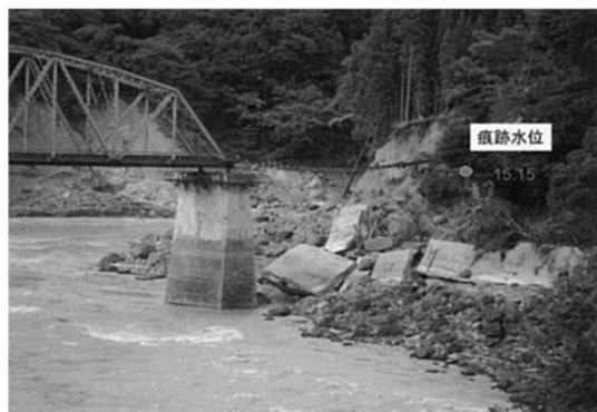
図-1.2.38 JR第5鉄橋（只見川 滝ダム下流 大沼郡金山町）上路プレートガーダの流出
