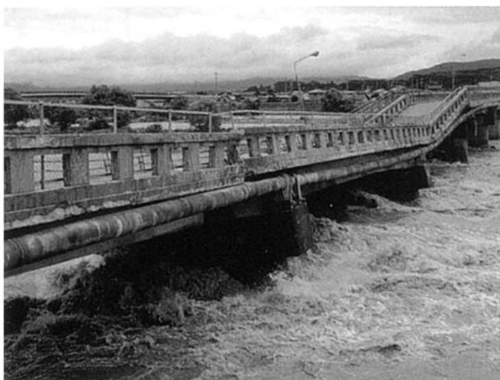
図-1.2.24 殿島橋 河床洗掘による橋脚の沈下
