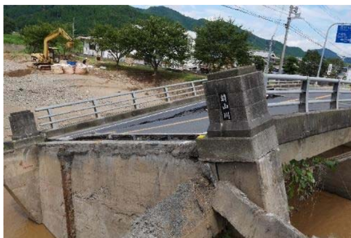
図-1.2.69 八日市橋(国道175号線) 橋台洗掘により橋が傾く [出典：伊津野]
