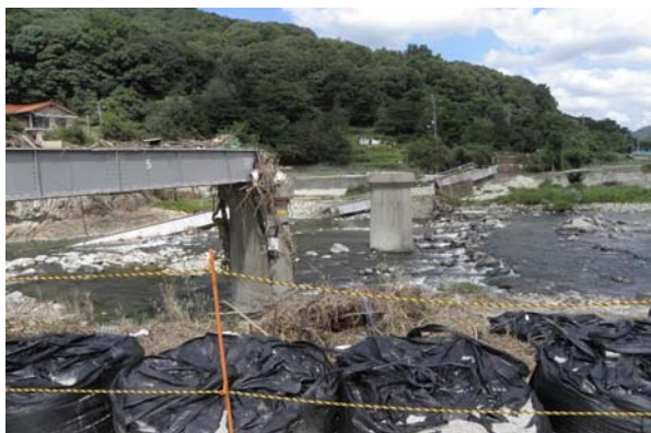
図-1.2.94 第一三条川橋梁 (JR 芸備線) 落橋 [出典：幸左]
