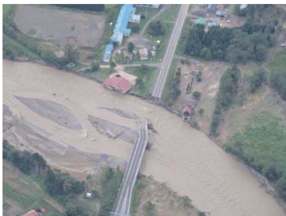
図-1.2.75 千呂露橋 落橋
