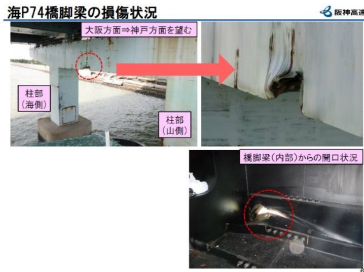
図-1.3.7 鳴尾橋の損傷 2
