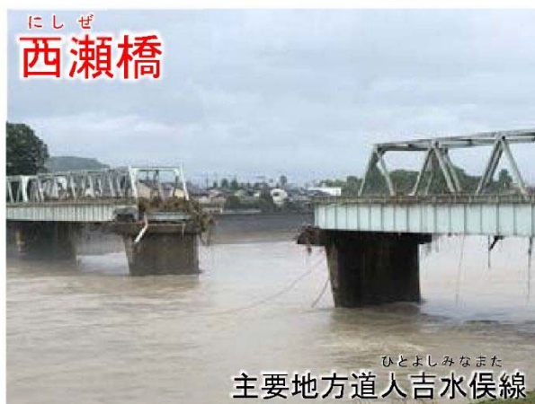
図-1.2.111 上部構造が流出した橋梁
