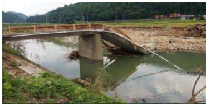
図-1.2.61 南河内橋 橋台の転倒および桁の落下
