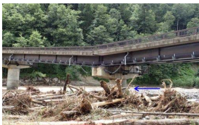
図-1.2.72 高原大橋(国道273号線) 洗掘による傾斜・沈下
