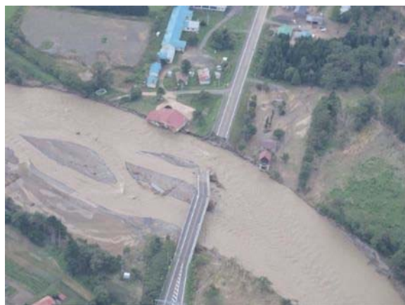
図-1.2.75 千呂露橋 落橋
