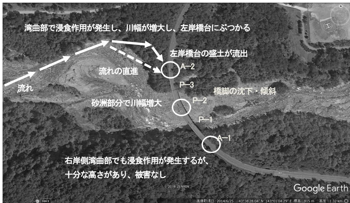
図-2.2.3 高原大橋の被災メカニズム (Google Earth 2014/6/25 に加筆)
