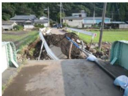
図-1.2.56 代官橋(大津町) 一部落橋
