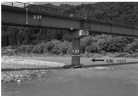
図-1.2.45 櫛戸橋（伊南川 滝ダム上流 南会津群只見町）橋脚の傾き
