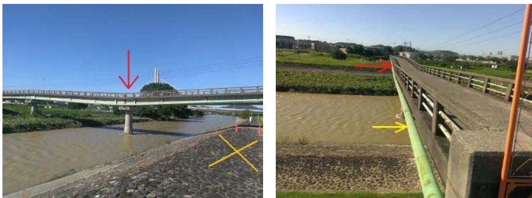
図-1. 2. 68 新北橋 橋脚沈下
