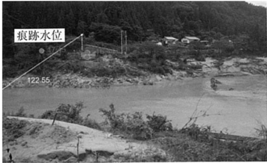
図-1.2.35 西部橋（只見川 滝ダム下流 大沼郡金山町）桁の流失
