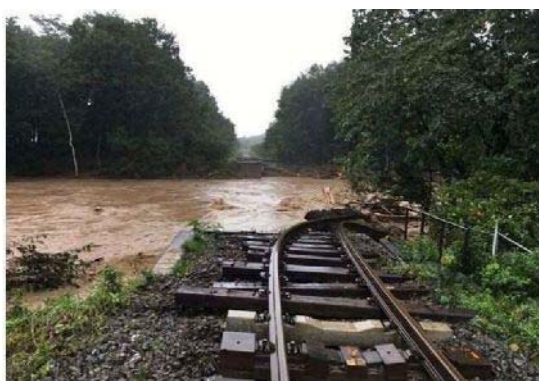
根室線 第1佐幌川橋梁 橋梁流失
