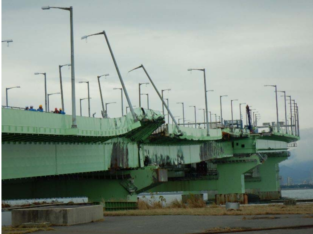
図-1.3.4 関西国際空港連絡橋の側面損傷状況[出典：伊津野]
