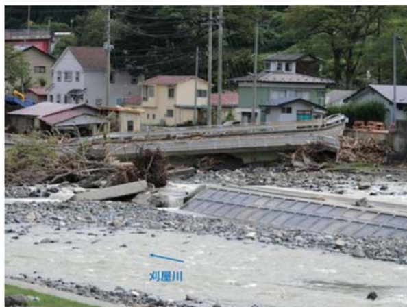
図-1.2.81 日陰橋 落橋
