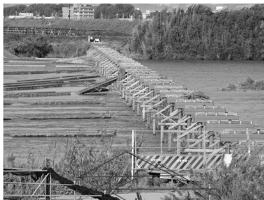
写真-2.1.3 洪水により流出した流れ橋（台風 19 号による被害 2019 年） 2.1.19)
