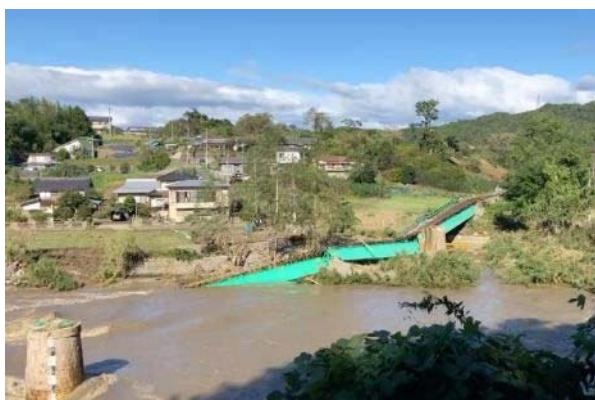
図-1.2.101 第6久慈川橋梁(JR水郡線) 落橋
