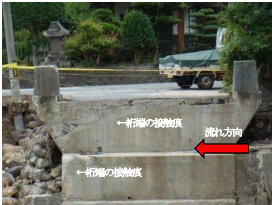
図-1.2.89 パラペットに残された桁の接触痕 [出典：佐藤]
