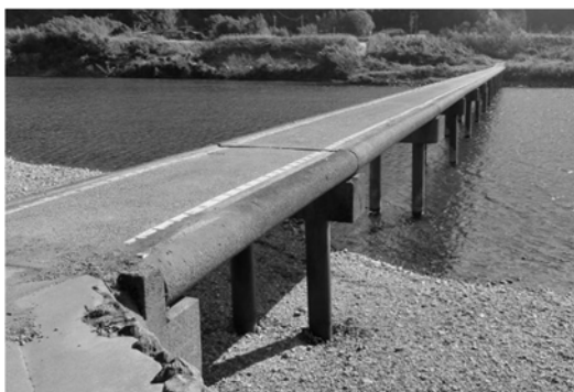
写真-2.1.1 沈下橋（高知県，三里沈下橋）
