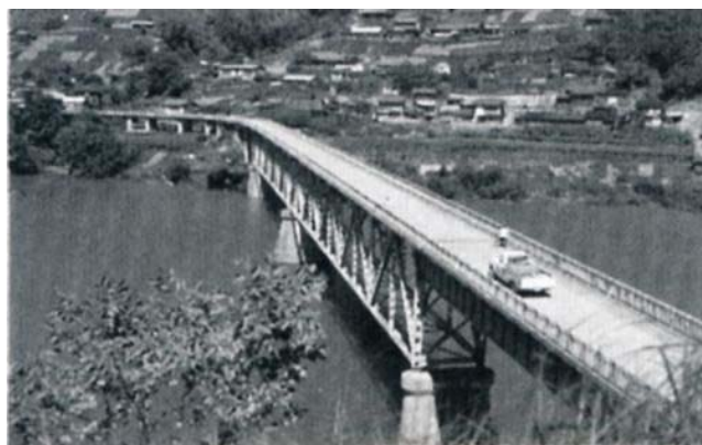
図-1.2.54 建設当時の折立橋
