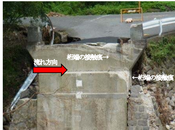
図-1.2.89 パラペットに残された桁の接触痕 [出典：佐藤]
