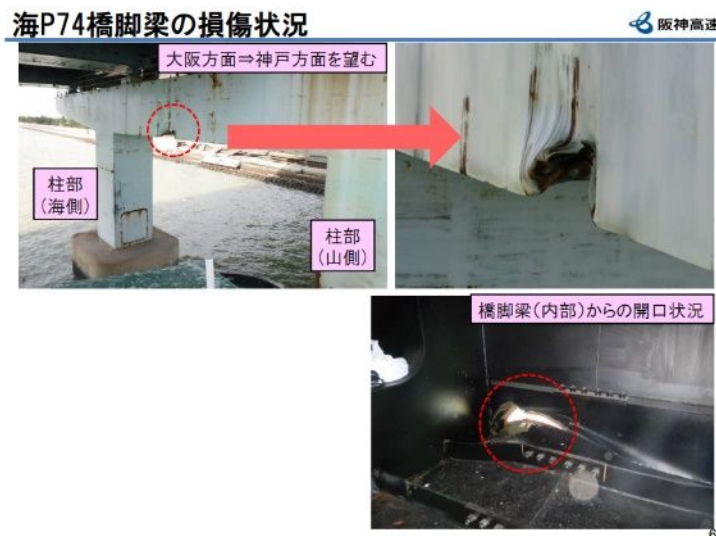
図-1.3.7 鳴尾橋の損傷 2
