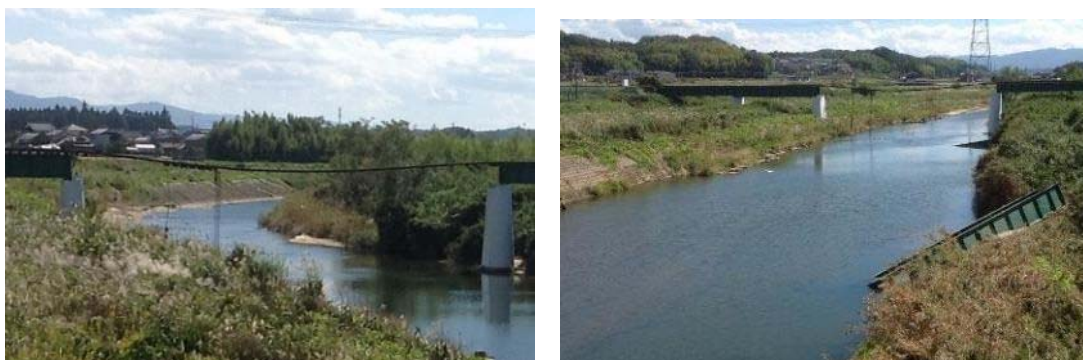
図-1.2.64 杣川橋梁(JR東海信楽高原鉄道) 橋脚1基と橋桁2本流出
