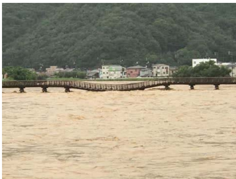
図-1.2.99 真光寺橋 流出前の状況
