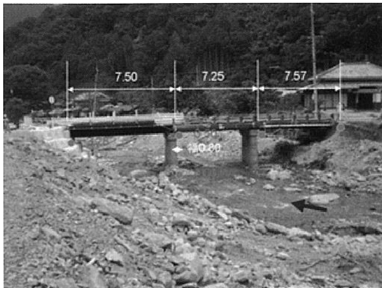
図-1.2.30 津羅橋 取り付け道路, 橋台, 橋桁の流出
