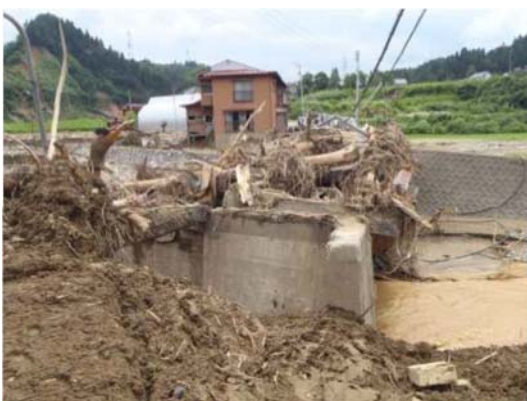
図-1.2.50 六箇橋（羽根川 十日町）落橋
