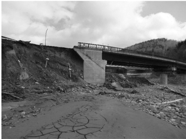
(a) A-2 橋台背面盛土の流失
