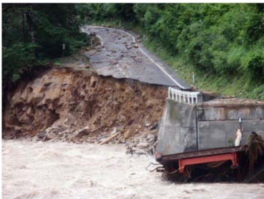
図-1.2.48 獅撫沢橋（只見川 魚沼市）流失
