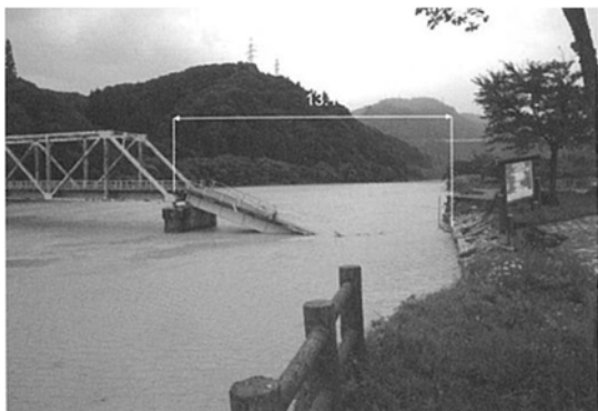
図-1.2.39 万代橋（只見川 滝ダム上流 南会津群只見町） 上路プレートガーダの流出
