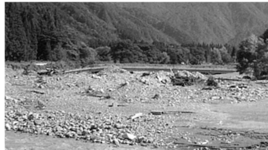
図-1.2.44 峯沢橋（黒谷川（伊南川支流）橋台の洗掘による倒壊
