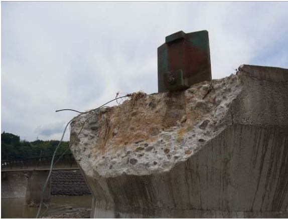
(4) 中間橋脚の橋座および支承の損傷
