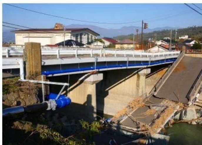
図-1.2.105 内村橋歩道橋 落橋
