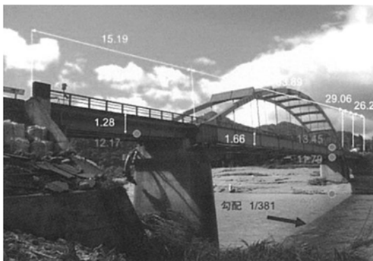
図-1.2.43 蒲生橋（只見川 滝ダム上流 南会津群只見町）洗掘による取り付け道路の流出
