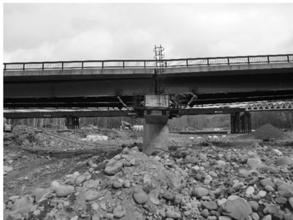
(c) P-2 橋脚の沈下
