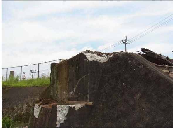
(3) 橋台部の損傷
