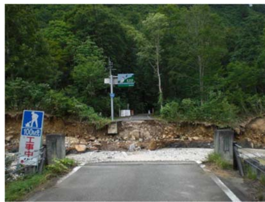
図-1.2.49 金泉橋（只見川 魚沼市）流失
