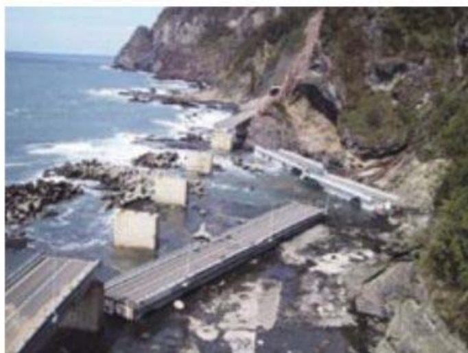
図-1.4.1 大森大橋 落橋 1.4.1)
