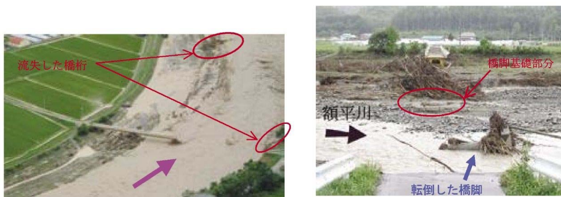
図-1.2.8 アブシトエナイ橋 橋脚転倒, 橋桁流出
