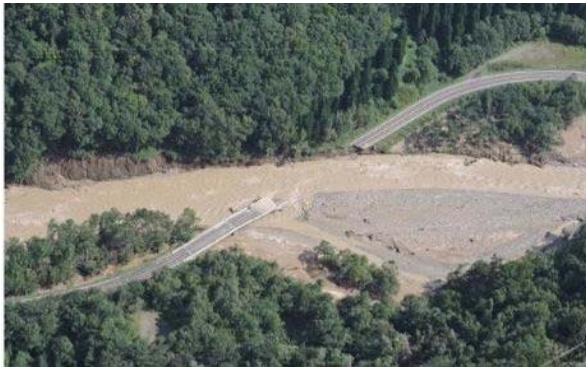
図-1.2.77 岩瀬橋 落橋
