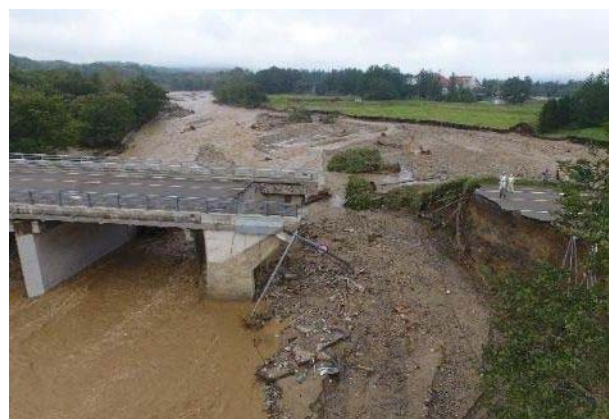
図-1.2.80 清見橋(ペケレベツ川) 洗掘による傾斜, 沈下
