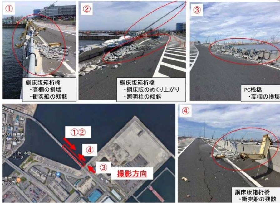
図-1.3.8 南本牧はま道路の損傷
