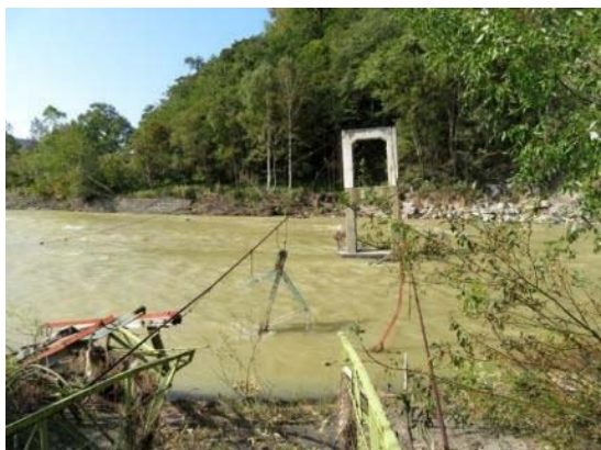
図-1.2.71 江差牛吊橋(人道橋) 落橋
