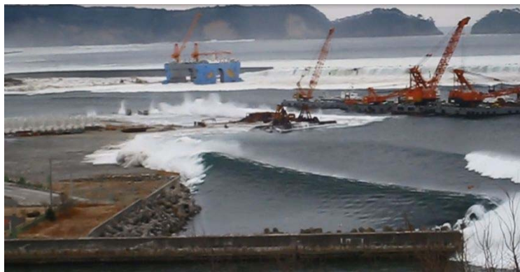
図-2.1.10 港内護岸に作用する津波形状
