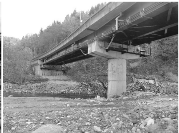
(d) P-1 橋脚と A-1 橋台
