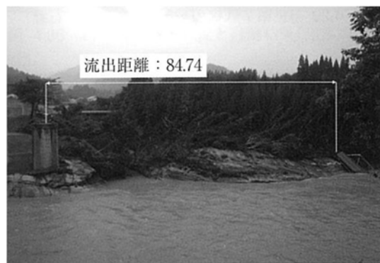
図-1.2.32 田沢橋(只見川 滝ダム下流 大沼郡金山町) 桁の流失
