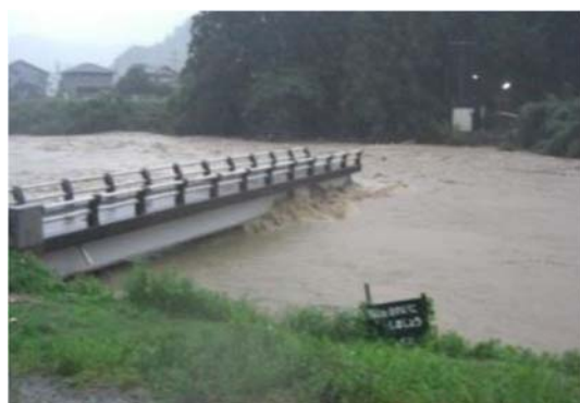
図-1.2.66 飛川橋 橋桁2径間と橋脚1基流失, 残る1基も洗掘
