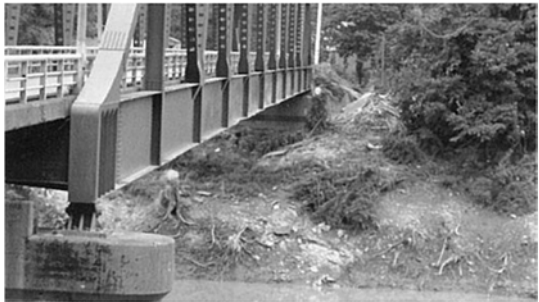
図-1.2.37 湯倉橋（只見川 滝ダム下流 大沼郡金山町）桁の変形
