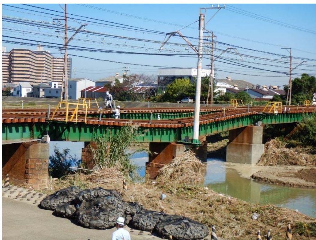
図-1.2.91 南海電鉄、男里川橋梁 橋脚沈下(洗堀) [出典:伊津野]
