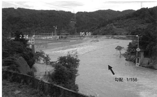
図-1.2.36 JR第6鉄橋（只見川 滝ダム下流 大沼郡金山町）桁の流失
