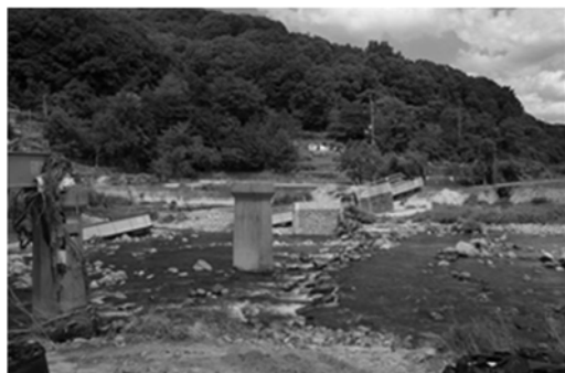
図-2.2.1 JR 芸備線第 1 三篠川橋梁
