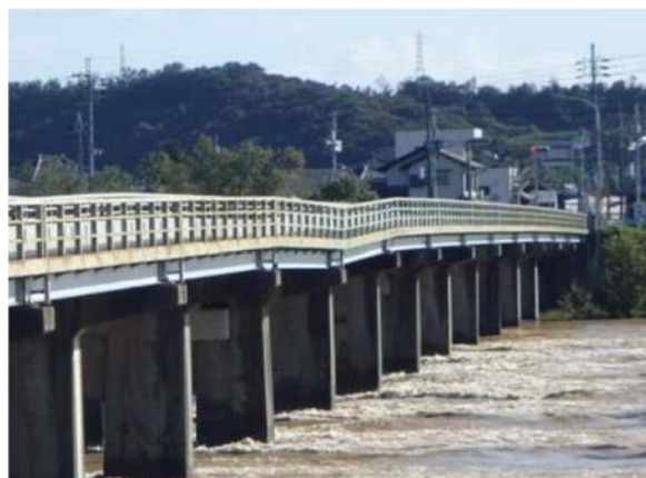
図-1.2.67 栗田橋 洗掘による橋脚沈下
