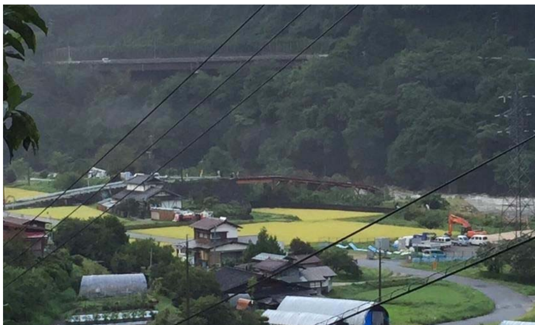
図-1.2.100 大桑橋 落橋
