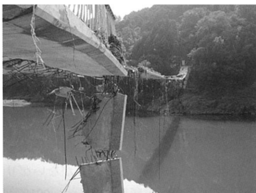
図-1.2.23 うさぎ橋(吊り橋式歩道橋) 流水流木により桁が破壊
