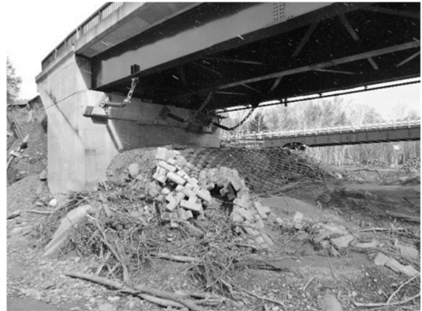
(b) A-2 橋台護岸の被害
