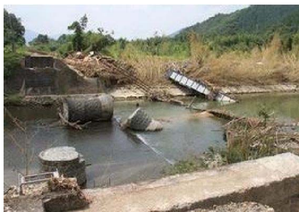
図-1.2.59 第5阿武川橋梁(JR西日本山口線) 流出
