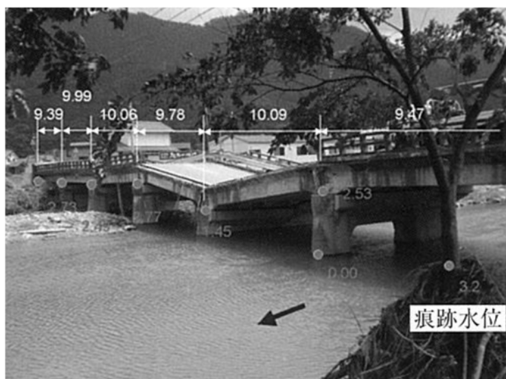
図-1.2.29 新橋 洗掘による橋脚沈下
