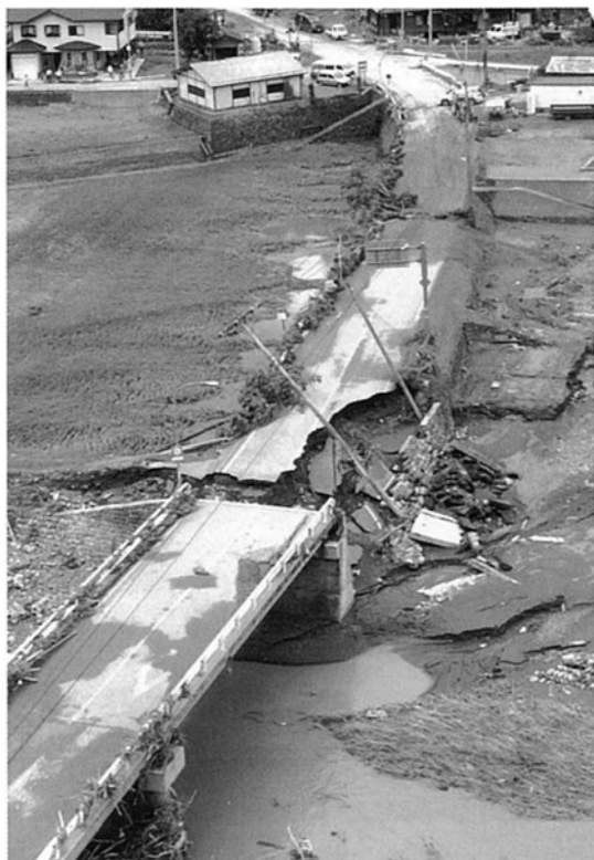
図-1.2.17 高田大橋(国道364号線) 取り付け道路崩壊
