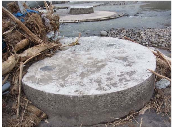
(5) 橋脚の破断面
