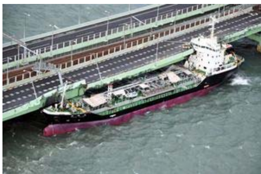
図-2.3.2.3 油タンカーの衝突状況
