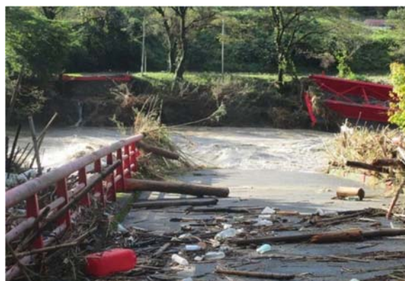
図-1.2.102 高地原橋 落橋
