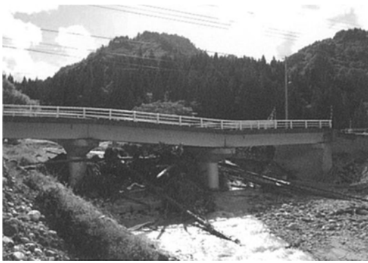
図-1.2.47 花立橋（伊南川 滝ダム上流 南会津群只見町） 護床工が流出し、洗掘により橋脚が沈下
