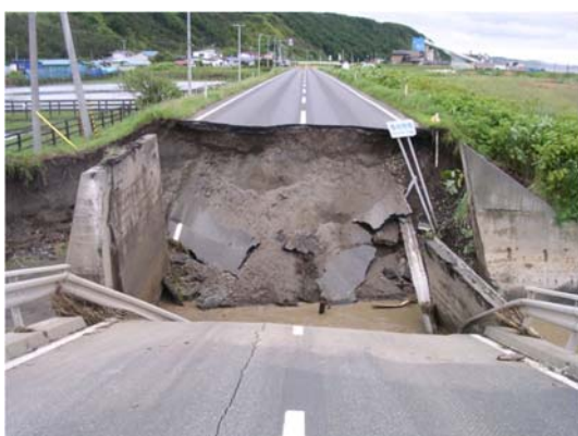
図-1.2.10 慶能舞橋 落橋、橋台洗掘
