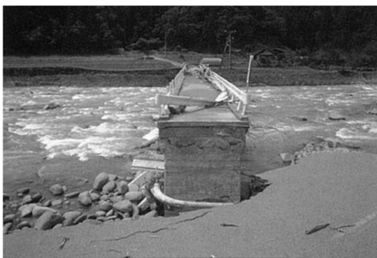
図-1.2.6 下向橋 迂回流による橋台背後の洗掘
