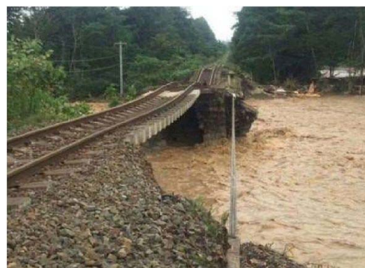
根室線 清水川橋梁 橋梁流失
