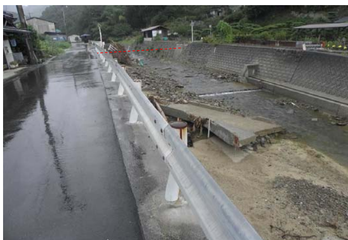
図-1.2.96 北川橋 落橋 [出典：幸左]
