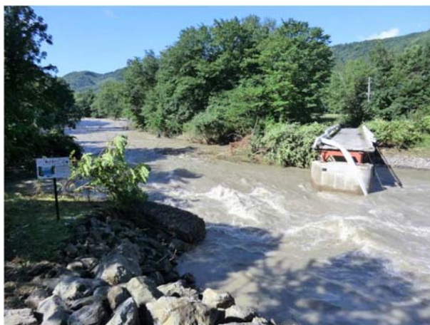
図-1.2.73 武利橋(町道) 落橋
