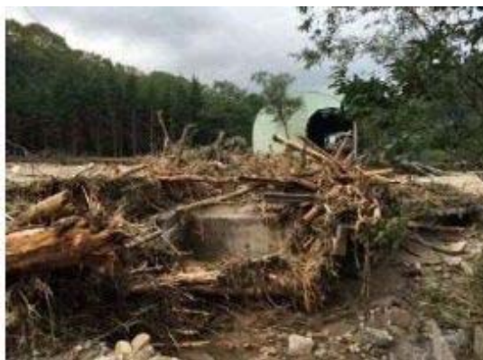
根室線 第2谷間川橋梁 線路流失
