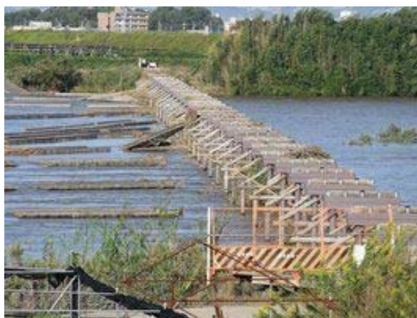
図-1.2.110 上津屋橋(通称・流れ橋) 橋板流出
