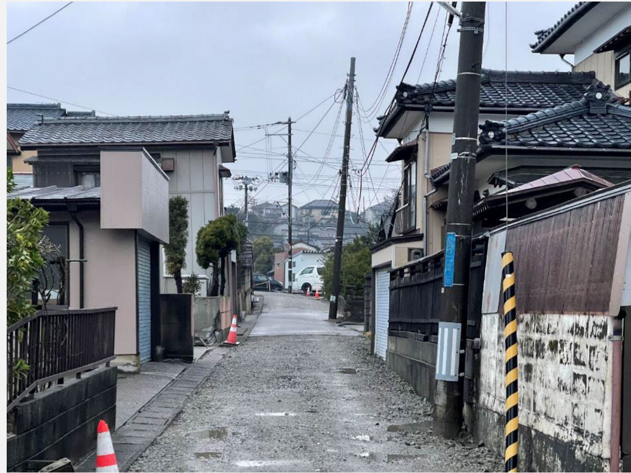
県道16号（南東側）に直行する生活道路沿いでも地盤変状と住宅の沈下・傾斜
