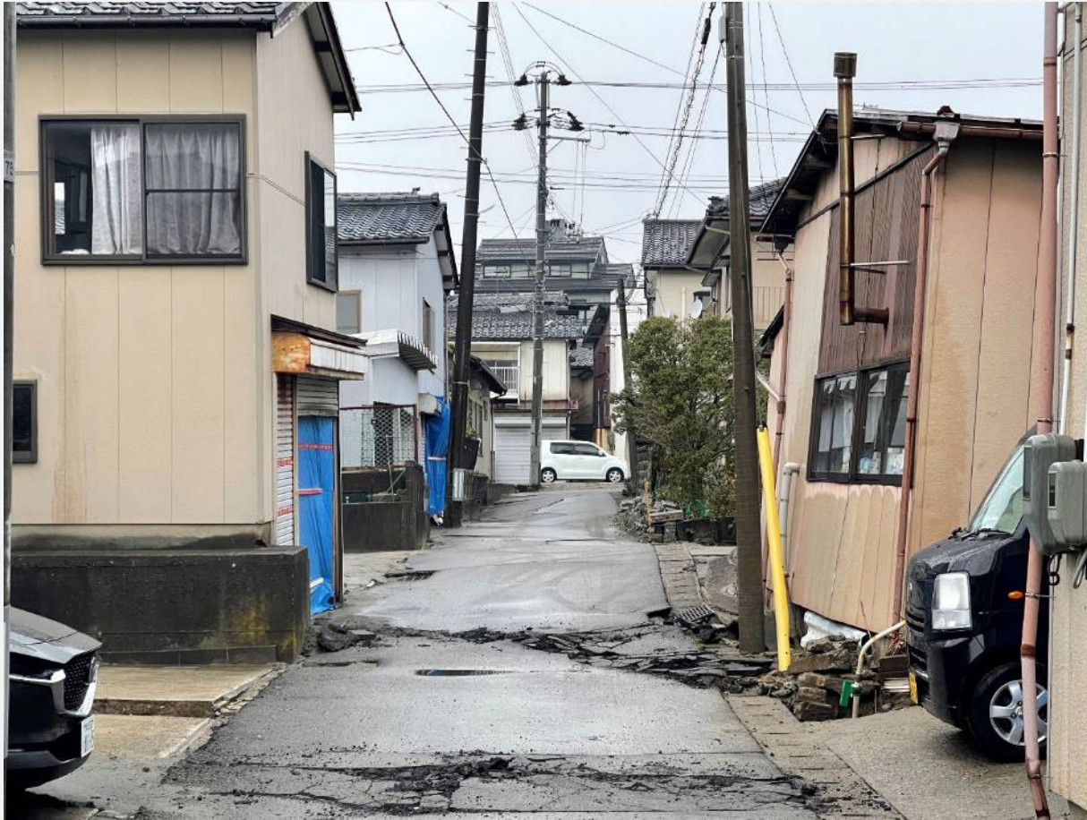
県道16号（南東側）に直行する生活道路沿いでも地盤変状と住宅の沈下・傾斜
