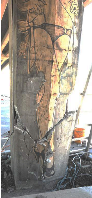
P4橋脚にせん断破壊が発生
