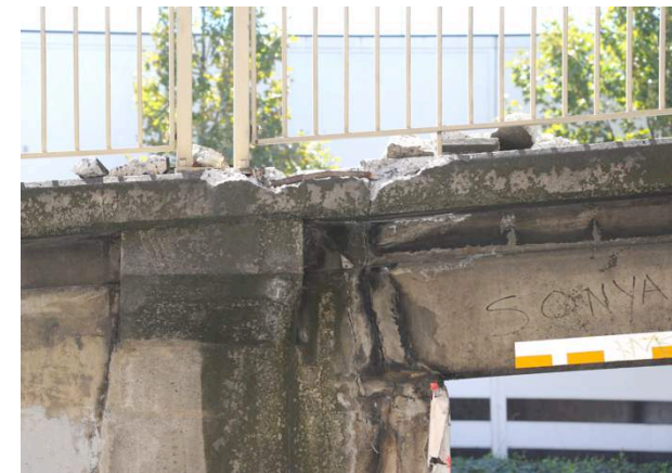
A2橋台で桁衝突
