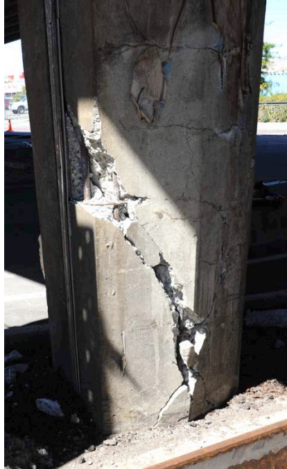
P4橋脚にせん断破壊が発生
