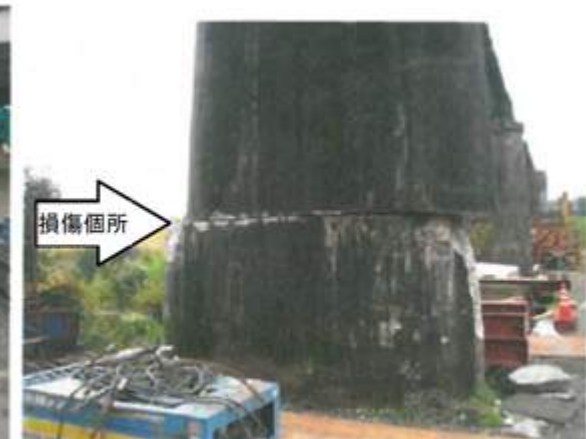
写真7 打継目での水平ずれ(14P) [27]
