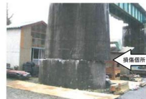
写真8 打継目での水平ずれ(15P) [27]
