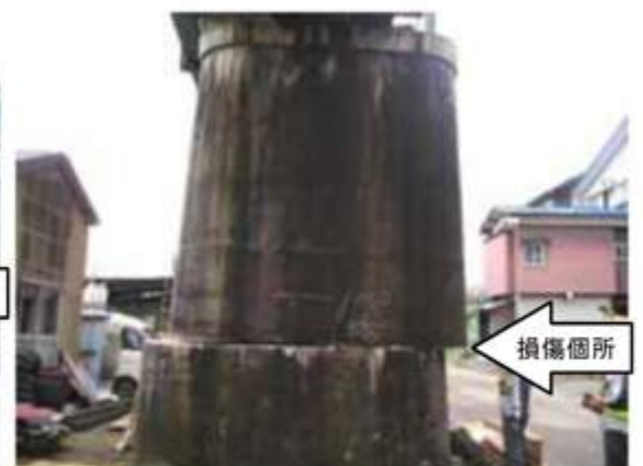
写真9 打継目での水平ずれ(15P) [27]
