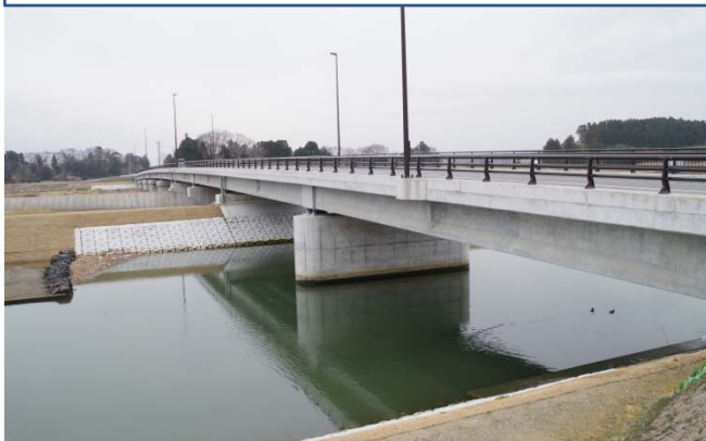
橋梁の全景：令和2年3月竣工
