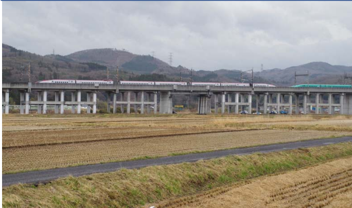
橋梁の全景：新幹線の脱線車両の復旧作業中。
