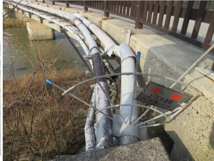
下水管PE250 地盤沈下に追随
