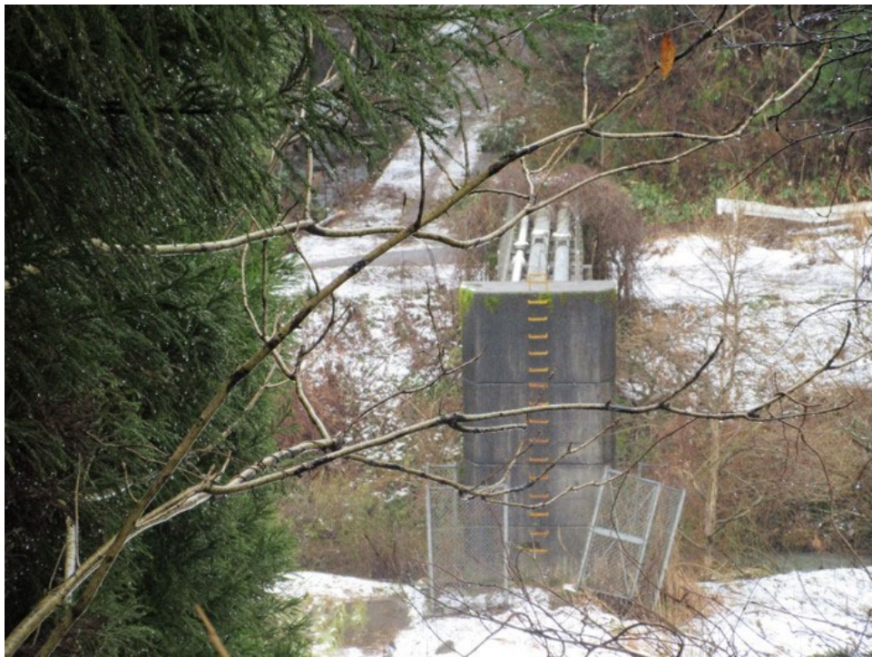
水管橋：ダムからの導水管(PPLP)、低区配水池、高区配水池への送水管、3つの管路が添架されている。
