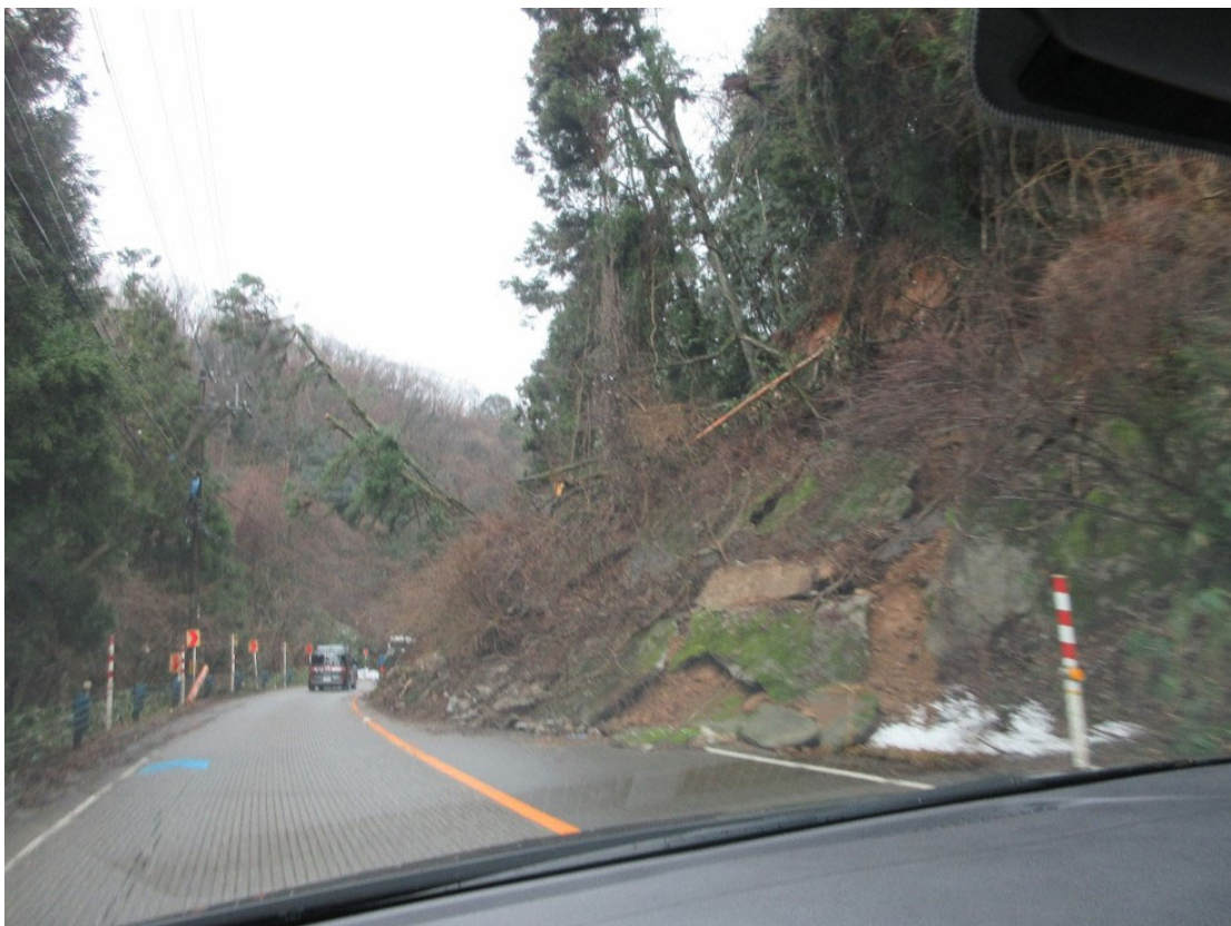
斜面崩壊。1車線分だけ確保。二次災害対策をしているわけではない。
