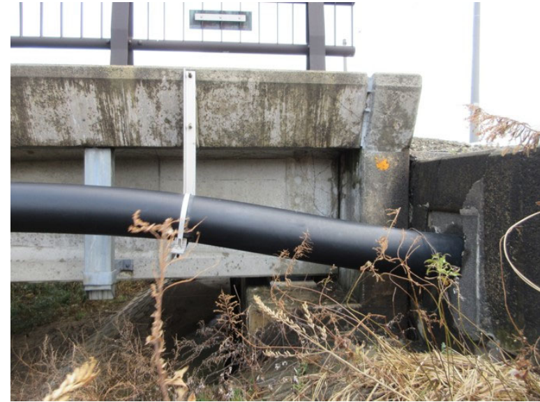
下水管PE250 地盤沈下に追随
