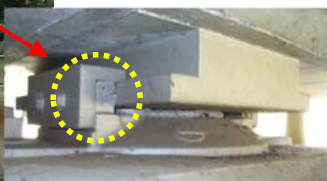
移動制限装置との接触痕
