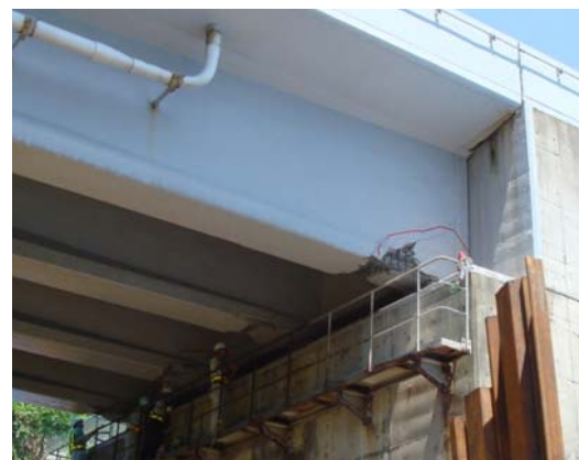
検査路により支承部の近接点検が容易
