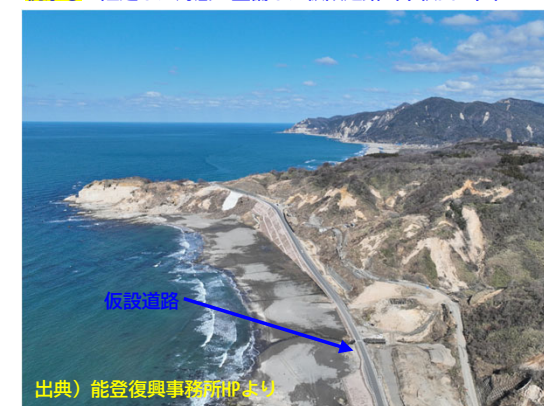
視察⑥：隆起した海底に整備した仮設道路（千枚田工区）
