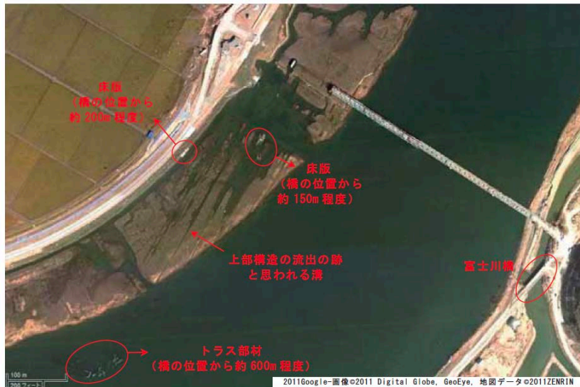
写真-3.21.4.1 A1～P2 間上部構造が流出した橋の状況
