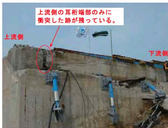
写真-3.4.23.11 A2橋台パラペットの損傷状況
