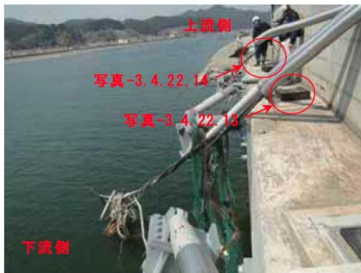
写真-3.4.22.11 A2 橋台沓座面の状況
