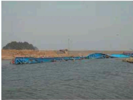
写真-3.4.23.4 流出した上部構造の状況
