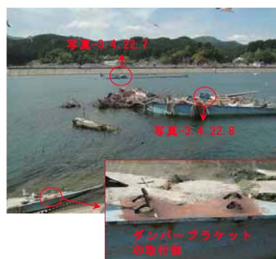
写真-3.4.22.6 流出した上部構造の状況
