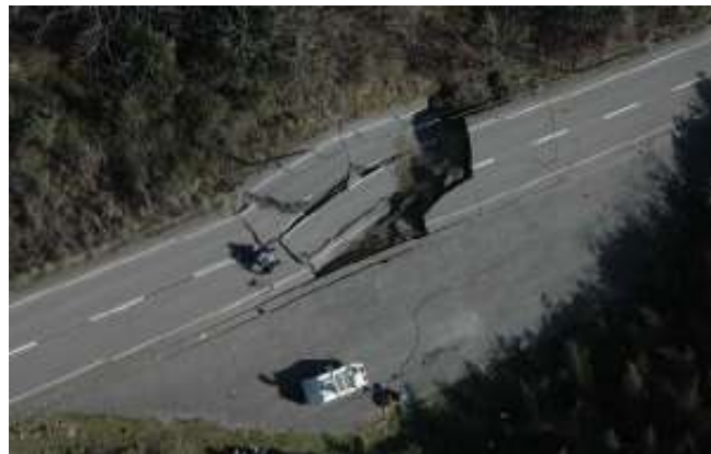
写真-1.1.43 志賀町深谷での崩壊 18)
