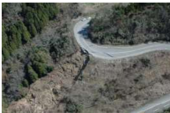
写真-1.1.44 志賀町大福寺での崩壊 18)
