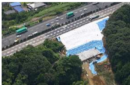
写真-1.1.55 牧之原地区盛土崩壊の応急復旧完了 24)
