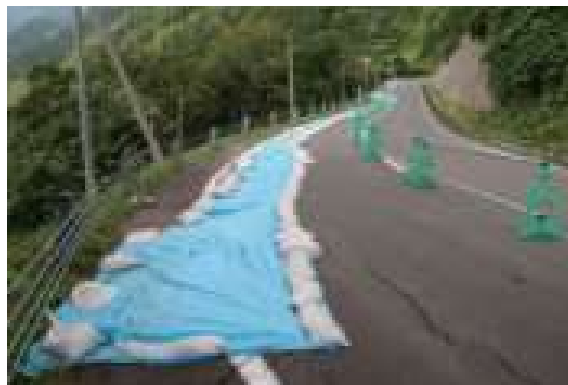
写真-1.1.49 雄勝郡東成瀬村での被害 21)
