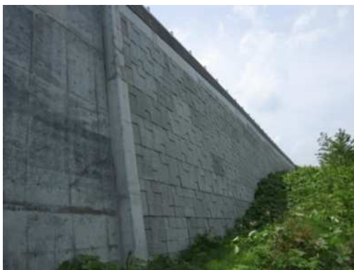
(c)補修後の壁面の状況
