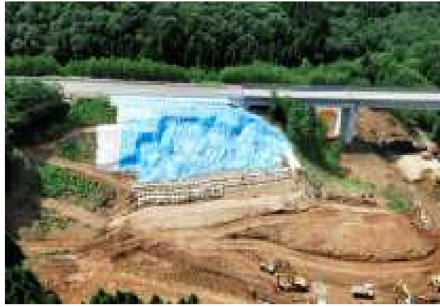
写真-1.1.42 応急復旧の状況 18)
