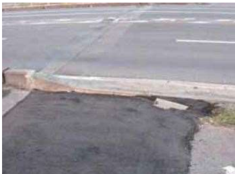
写真-1.2.47 左岸側橋台背面の補修状況（矢田川橋） 27)
