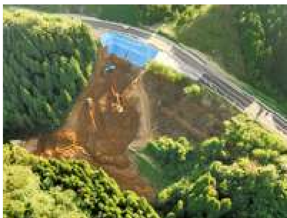
写真-1.1.29 応急復旧の状況 18)
