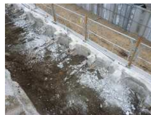
(a) 笠コンクリートの撤去
