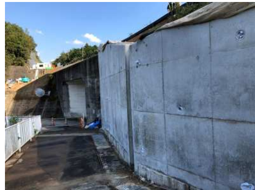
(b) 補修後の状況
