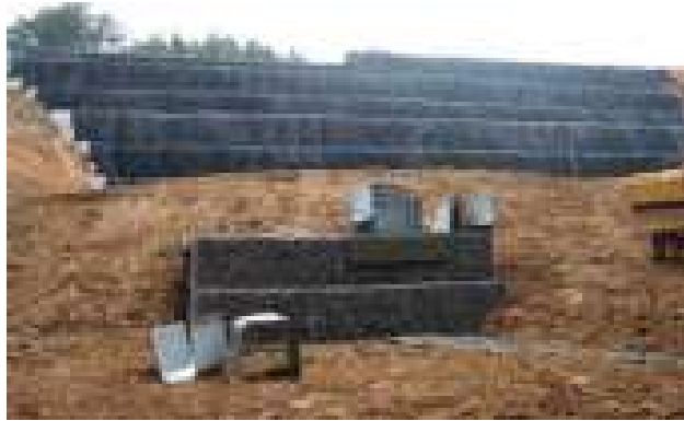
写真-1.1.27 応急復旧の状況 18)
