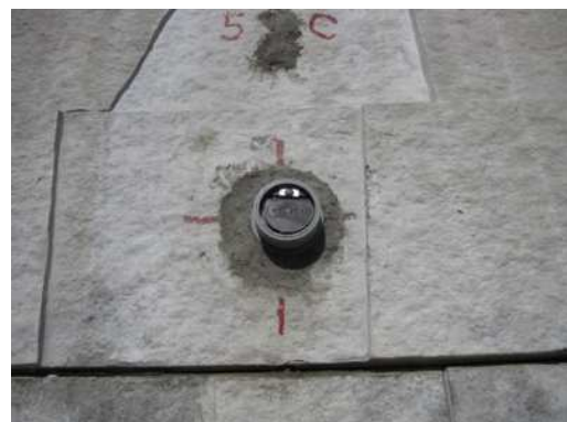
(b) 逆流防止弁の設置
