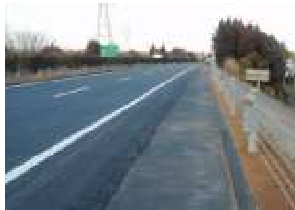
写真-1.1.65 応急復旧の状況 27)
