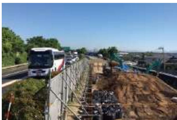
写真-1.1.73 応急復旧状況 33)
