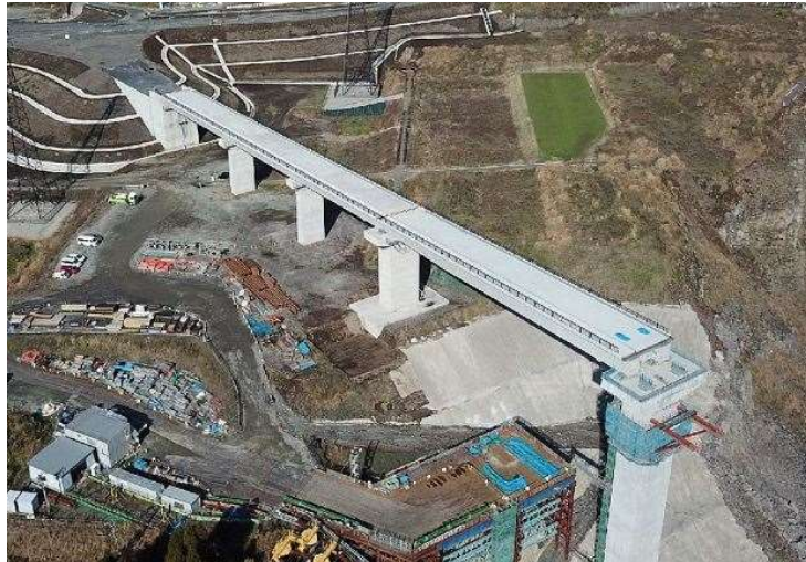
写真-1.2.57 復旧作業状況（阿蘇大橋） 33)
