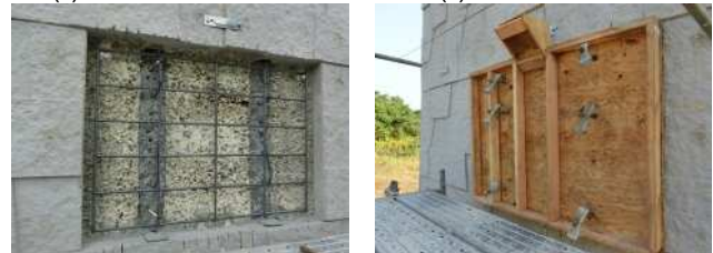
(c) 鉄筋の配筋 (d) 型枠の設置
