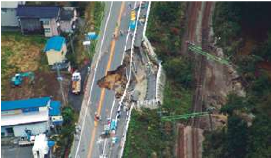
写真-1.1.9 被災直後の天納地区での崩壊 12)
