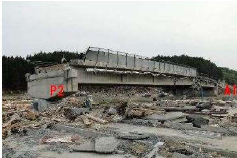
写真-1.2.34 津波後の A1 橋台から P2 橋脚の状況（歌津大橋） 24)
