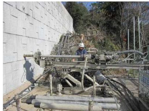
(a) 排水パイプの打設
