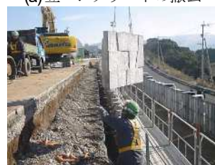
(c) 壁面材の撤去
