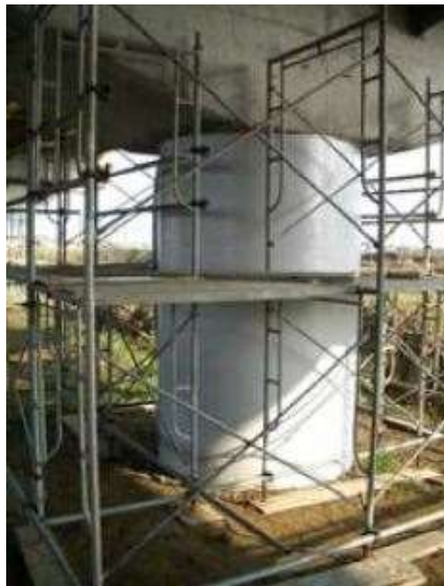
写真-1.2.2 炭素繊維シート巻き立てによる応急復旧（新組跨線橋） 12)
