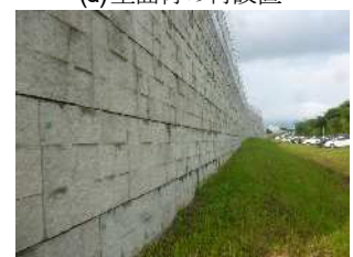
(f) 補修完了
