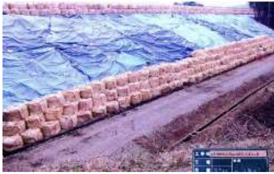
写真-1.1.59 8.9kp での応急復旧 27)
