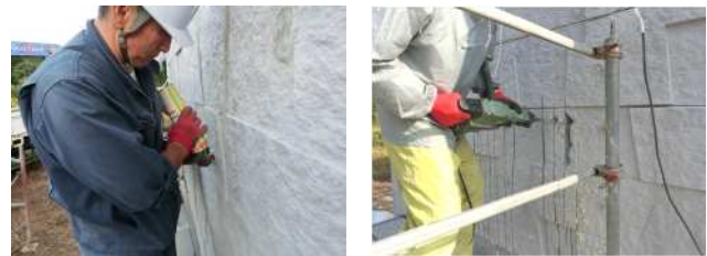
(a) 発泡ウレタンの注入 (b) 壁面材のはつり
