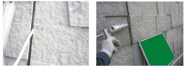
(a) バックアップ材の設置 (b) コーキング材の充填
