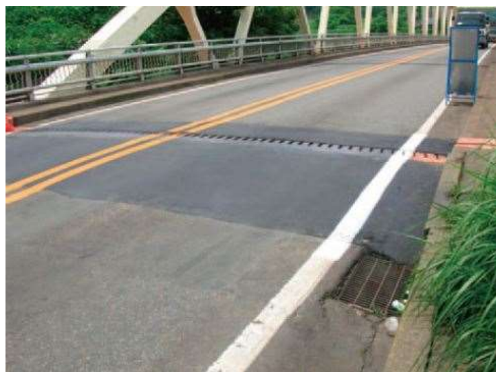
写真-1.2.28 橋面の段差被害の補修（胞姫橋） 18)
