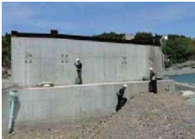
写真-1.2.45 上部構造の流出（新相川橋） 27)
