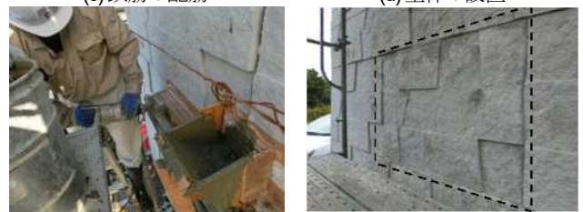
(e) コンクリートの打設 (d) 完了
