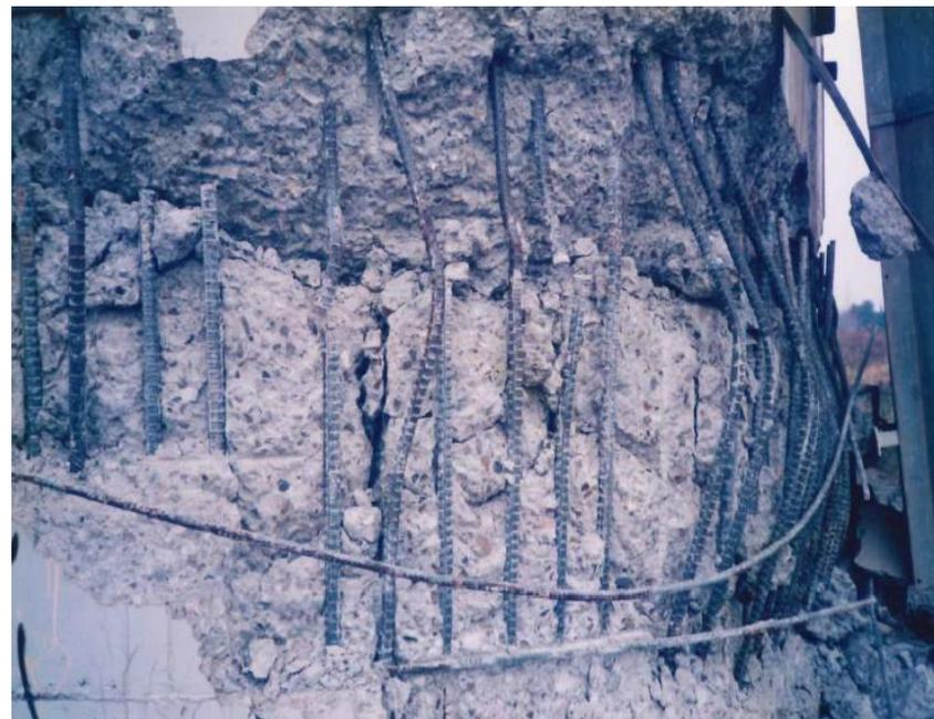
軸方向鉄筋の段落とし部のコンクリートが剥落
