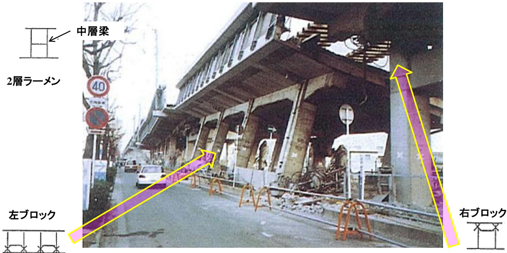
**2層ラーメン高架橋の左ブロックは中層梁の下部の柱が破壊。右ブロックは上部の柱が破壊した。**
