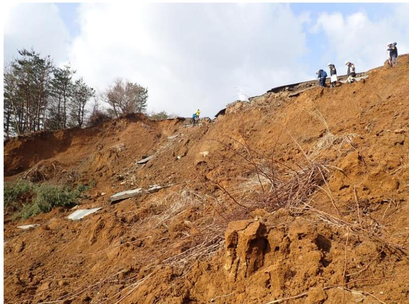
上部の舗装された部分には大きな亀裂が複数発生。頭部付近で湧水も確認された。雪解けとみられる地下水の供給があったものと考えられる。
