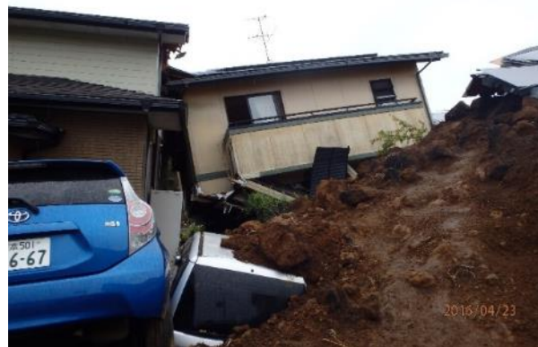
崩壊した土砂を受けた家屋
