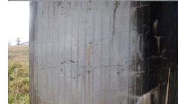
段落とし部での水平ひび割れ
