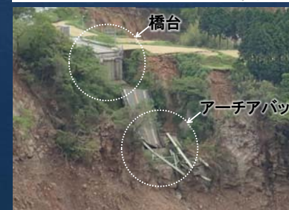
左岸側橋台とアーチアバット
