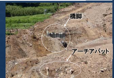
右岸側橋脚とアーチアバット
