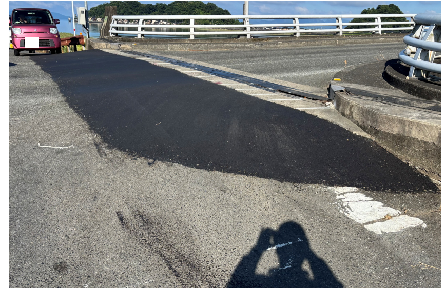
【損傷箇所の応急復旧】
